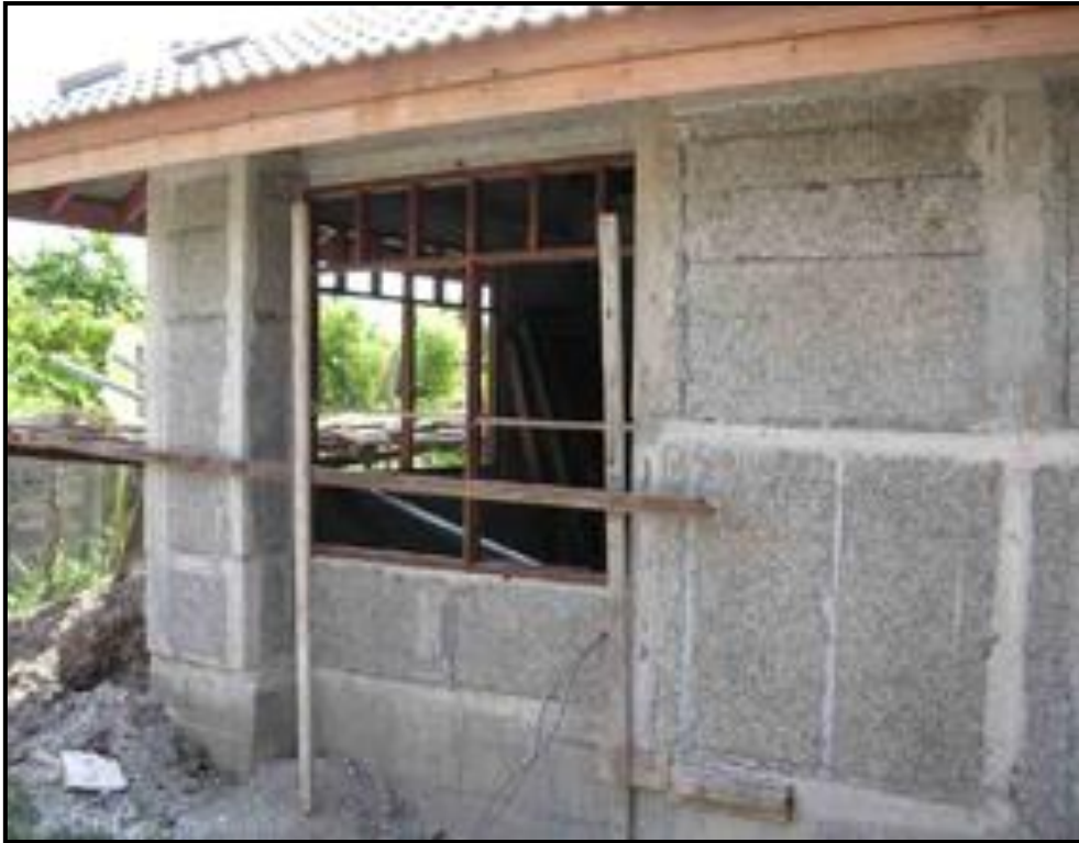
รูปที่ 3.7 งานก่อสร้างที่ใช้เซลโลกรีตเป็นวัสดุก่อผนัง
