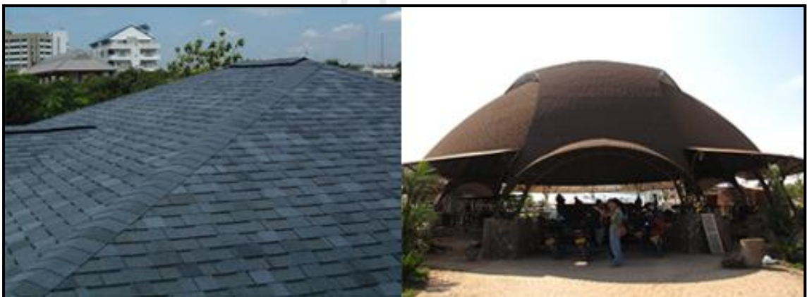
รูปที่ 3.12 หลังคาที่มุงด้วยวัสดุแอสฟัลต์
