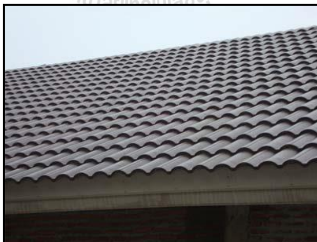
รูปที่ 3.10 การใช้กระเบื้องคอนกรีตเป็นวัสดุหลังคา
