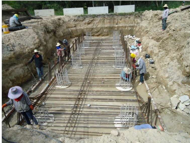
รูปที่ 8 งานก่อสร้างฐานเสาตอม่อ
