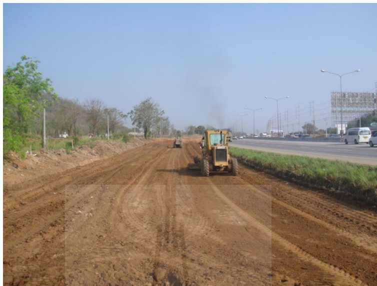
รูปที่ 4 งานก่อสร้างถนน
