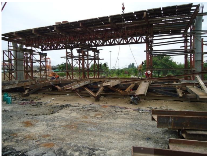
รูปที่ 10 งานตั่งน้ร้านพื้นสะพาน
