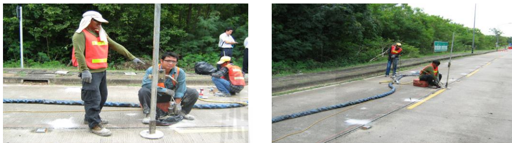
รูปที่ 2.8 การตรวจค่าระดับหลังฉีดสารยูรีเทค พ.ศ.2552
