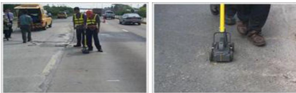
รูปที่ 2.4 การตรวจสอบโพรงใต้พื้นถนนคอนกรีต
