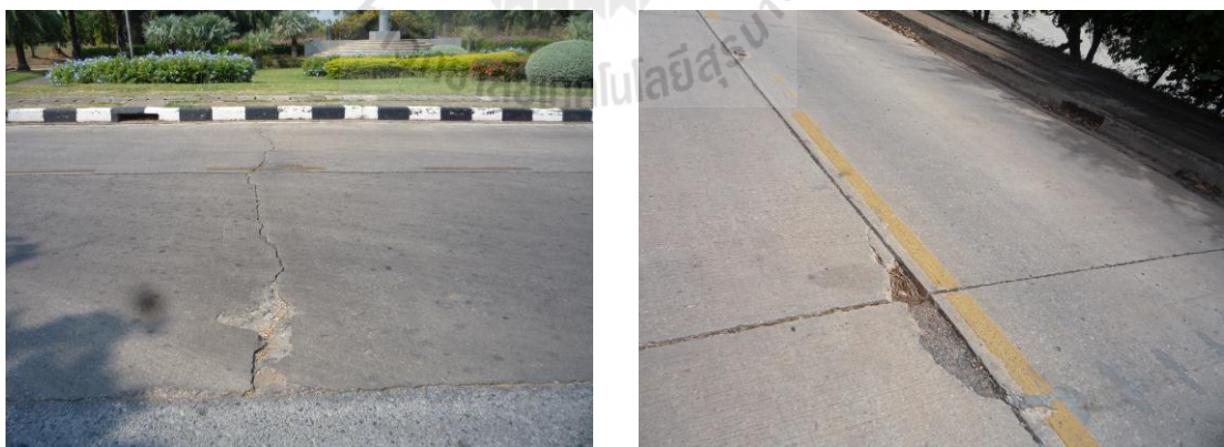
รูปที่ 4.9 การกะเทาะหลุดร่อนของรอยแตก
