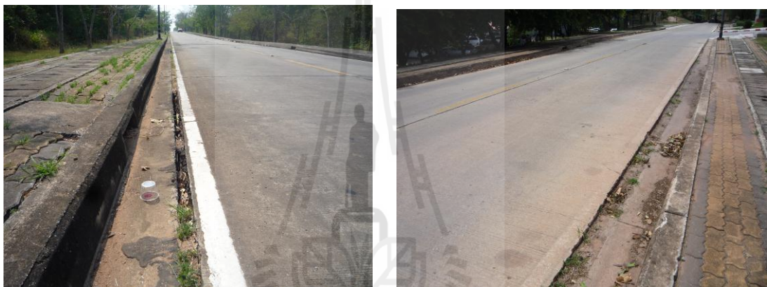
รูปที่ 4.8 ช่องทางจราจร และไหล่ทางยุบ
