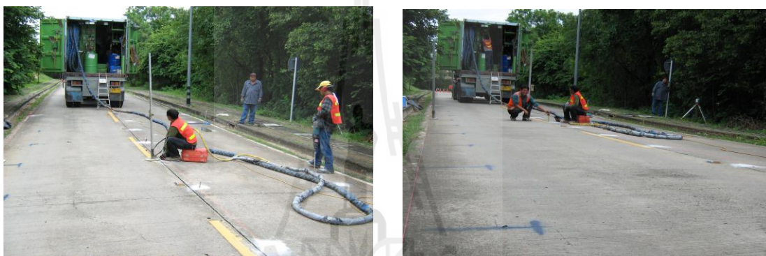
รูปที่ 4.19 การซ่อมแซมอุดโพรงแผ่นพื้นคอนกรีตผิวทางแบบนิตสาร โพลียูรีเทค เมื่อปี พ.ศ.2552
