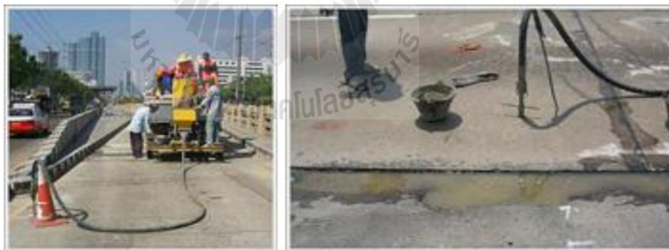
รูปที่ 2.6 การอัดน้ำปูน (Sub Sealing)
