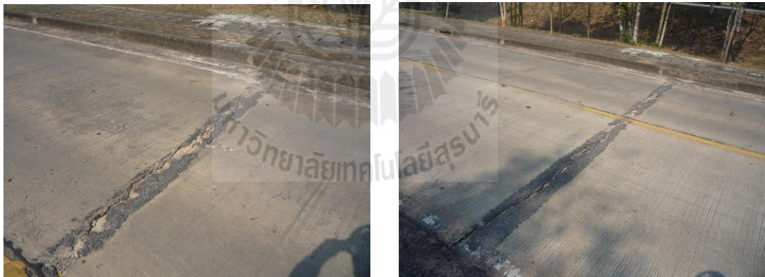
รูปที่ 4.11 การเลื่อน หรือยกตัวของรอยต่อตามขวางหรือรอยแตก
