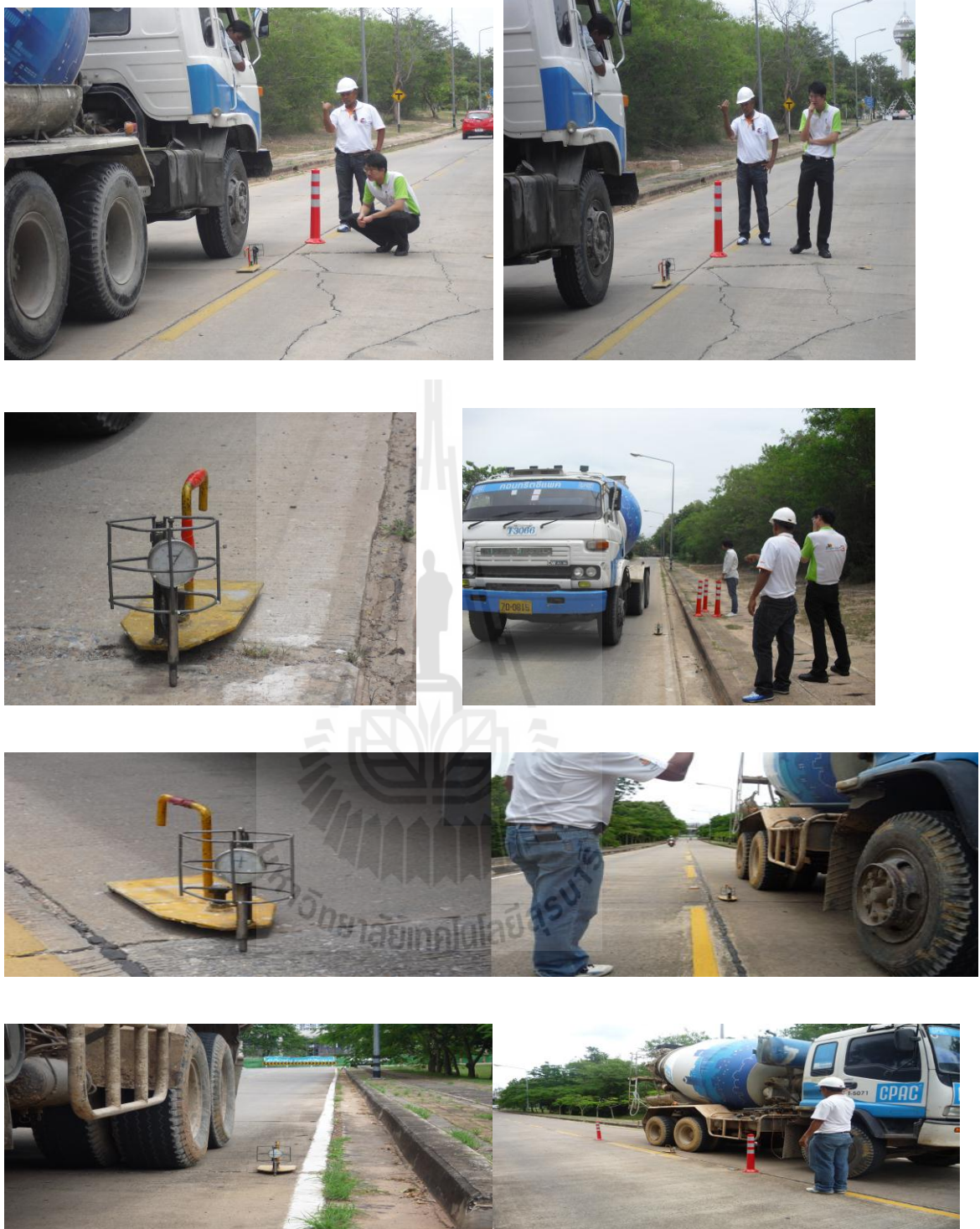
รูปที่ 4.24 การทดสอบค่ายวบตัวของแผ่นพื้นคอนกรีต
