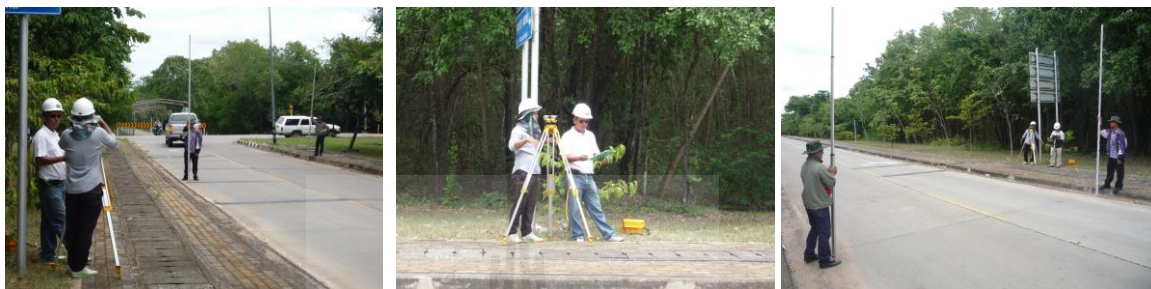
รูปที่ 3.1 การวัดค่าการทรุดตัวของแผ่นพื้นถนนคอนกรีตเสริมเหล็ก
