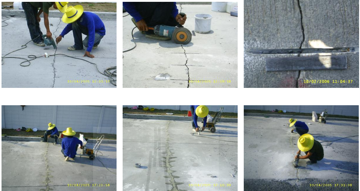
รูปที่ 4.17 ขั้นตอนการทำงานซ่อมรอยร้าวด้วย Epoxy Injection
