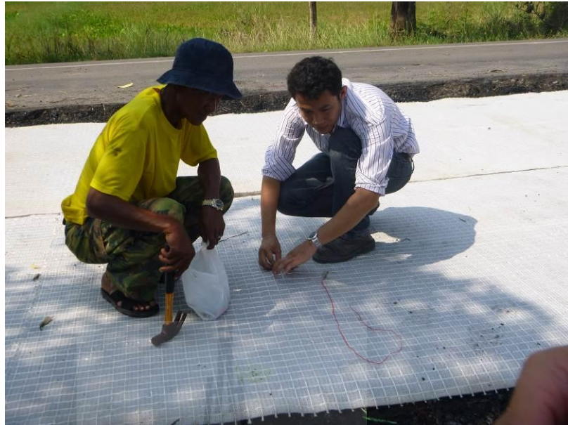
รูปที่ 4.7 ขั้นตอนการติดตั้ง Strain Gauge
