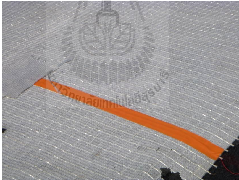
รูปที่ 4.9c ขั้นตอนการติดตั้ง Strain Gauge
