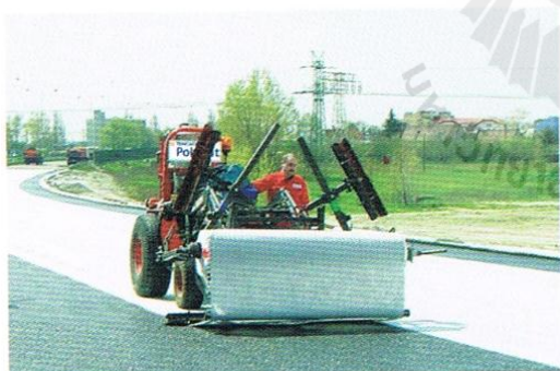
การติดตั้งทำได้ง่ายและรวดเร็วสามารถติดตั้งได้แม้เป็นแนวโค้ง
