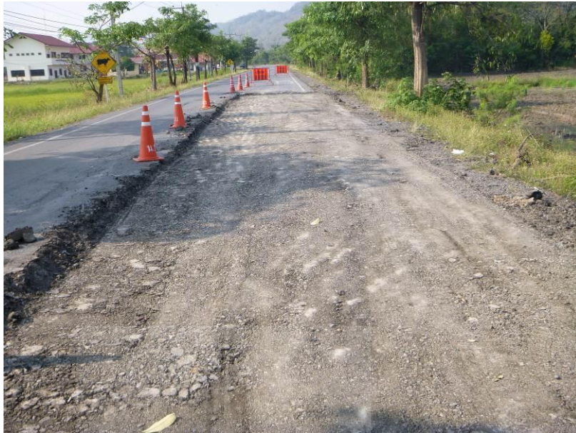
รูปที่ 4.3 ขั้นตอนการขุดหรือผิวทางเก่าออก
