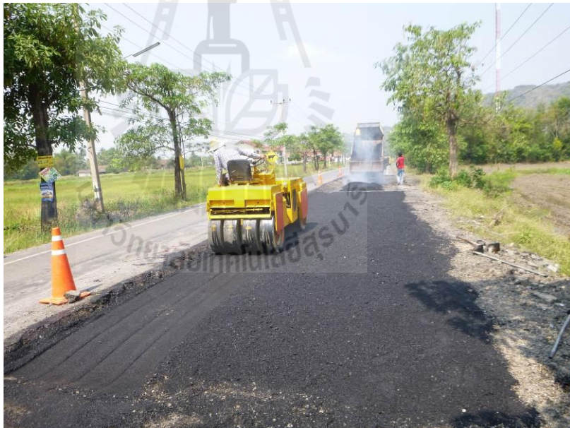
รูปที่ 4.4 ขั้นตอนการปูและบดอัดชั้นแอสฟัลต์คอนกรีต
