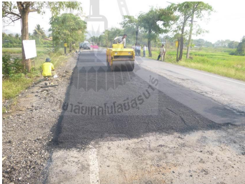
รูปที่ 4.8 ขั้นตอนการบดอัดแอสฟัลต์คอนกรีต
