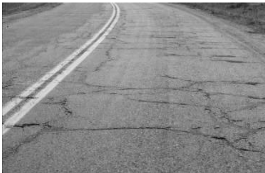
รูปที่ 2.1 ผิวทางลาดยางแตกร้าวแบบหนังจระเข้
