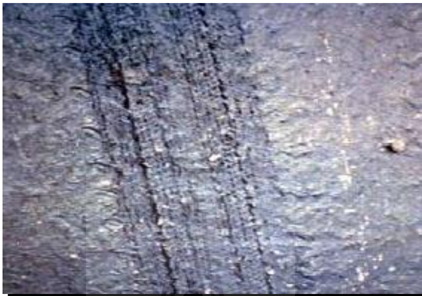
รูปที่ 2.6 การเยิ้มของแอสฟัลต์
