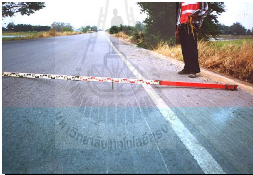
รูปที่ 2.3 ผิวทางลาดยางทรุดตัวเป็นร่องล้อ
