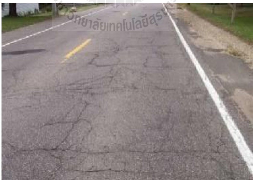
รูปที่ 2.2 ผิวทางลาดยางแตกร้าวจากการหดตัว
