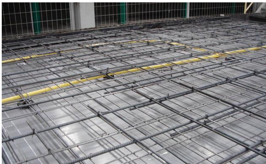
รูปที่ 2.6 การวางอุปกรณ์ และฝังท่อไฟก่อนการเท ( Pruksa Real Estate , 2006)
