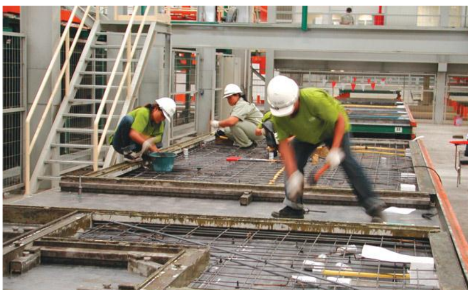
รูปที่ 2.5 การวางเหล็กเสริม ( Prukxa Real Estate , 2006)
