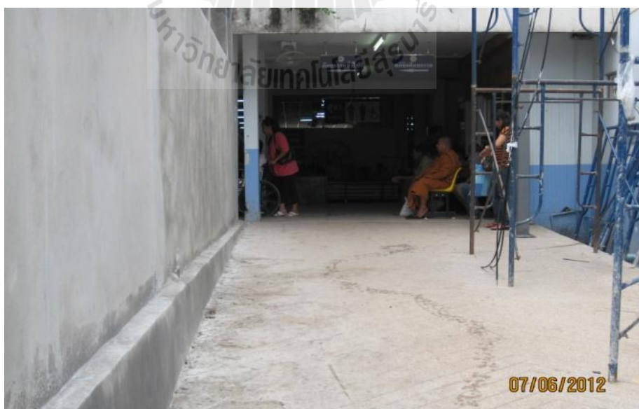
รูปที่ 4.12 ทางลาดด้านข้างอาคาร
