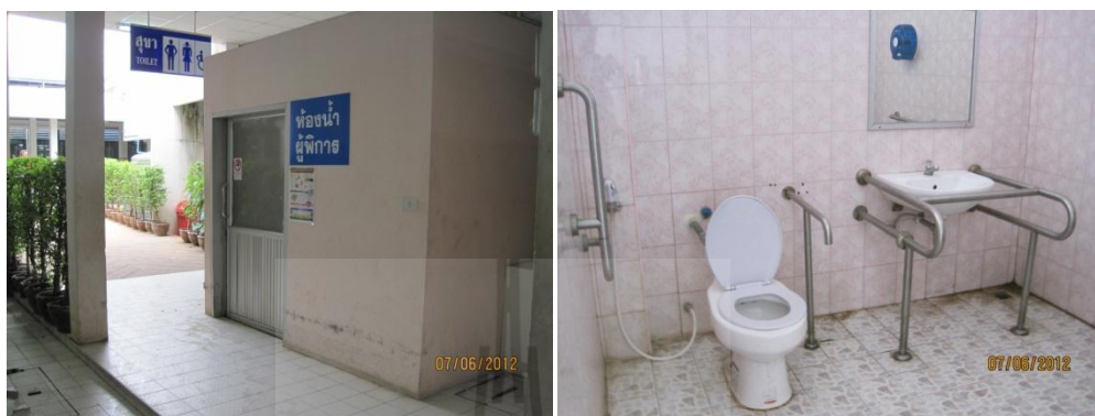
รูปที่ 4.23 ห้องน้ำคนพิการชั้นล่าง
