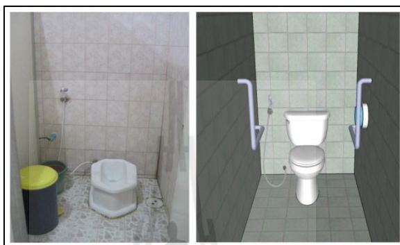
รูปที่ 4.46 เปรียบเทียบลักษณะของห้องน้ำชาย / หลุ่ยชั้นล่างก่อนปรับปรุง (ซ้าย) และข้อเสนอแนะในการปรับปรุง (ขวา)
