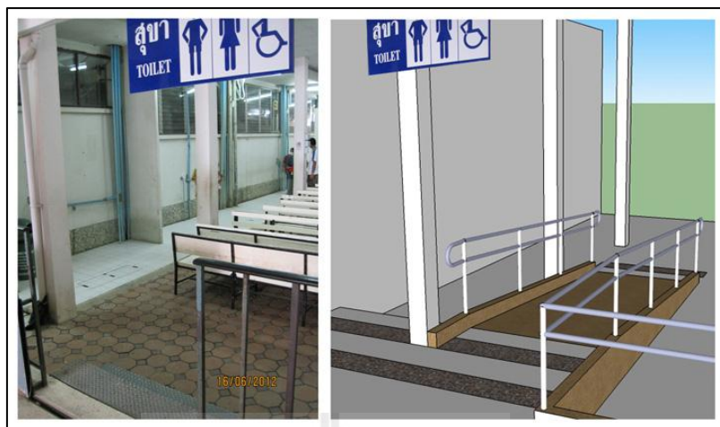
รูปที่ 4.40 ลักษณะของทางลาดสู่ห้องน้ำด้านหน้าอาคาร
