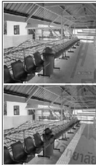
รูปที่ 6 4 เปรียบเทียบการติดตั้งพื้นผิวต่างสัมผัสก่อนปรับปรุง (บน) และข้อเสนอแนะในการปรับปรุง (ล่าง)
