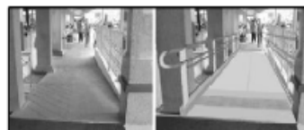
รูปที่ 1 เปรียบเทียบทางลาดก่อนปรับปรุง (ซ้าย) และข้อเสนอแนะในการปรับปรุง (ขวา)
