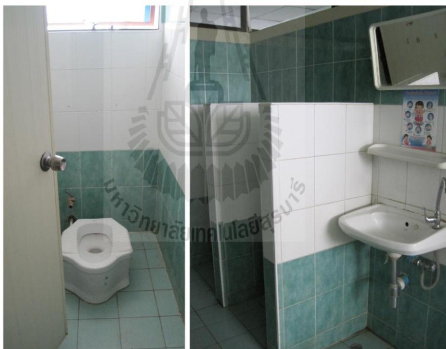
รูปที่ 4.25 ห้องน้ำชั้นบนด้านหน้าอาคาร
