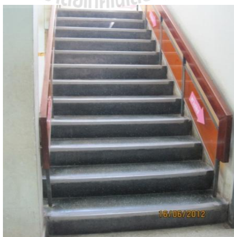
รูปที่ 4.15 บันไดด้านหลังอาคาร
