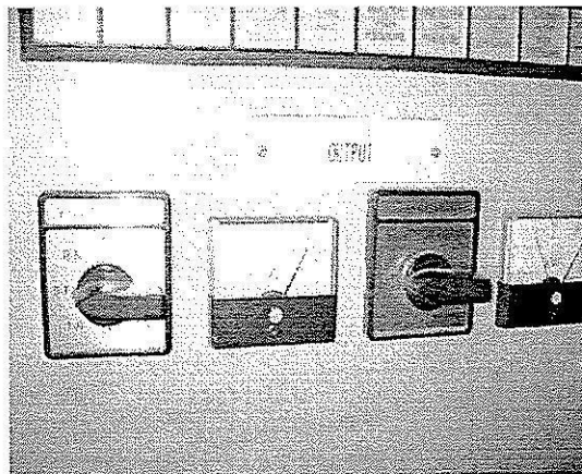
(จ) ติดตั้งระบบควบคุม Electric control panel
