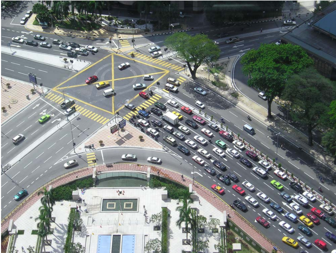
รูปที่ 3.6 สภาพทางกายภาพของทางแยกสี่สัญญาณไฟจราจร
