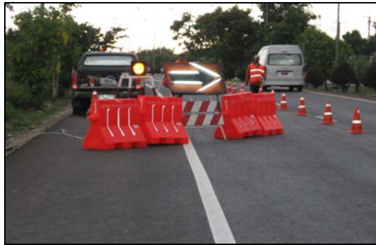
รูปที่ 3.13 การติดตั้งป้ายควบคุมการจราจรที่ 5 ป้ายเตือนแนวทางไปทางขวา ติดตั้งประกอบกับแผงกั้น
