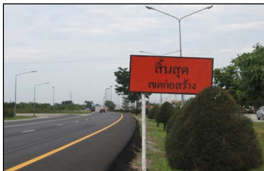
รูปที่ 3.14 การติดตั้งป้ายควบคุมการจราจรที่ 6 ป้ายสิ้นสุดเขตก่อสร้าง
