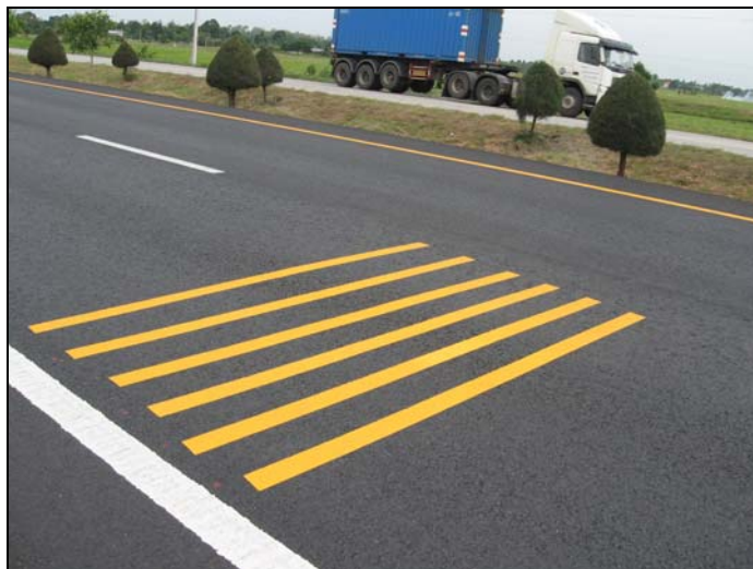
รูปที่ ซ.4 การติดตั้งแล้วเสร็จเปิดการจราจรตามปกติ
