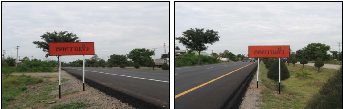
รูปที่ 3.12 การติดตั้งป้ายควบคุมการจราจรที่ 4 ป้ายเตือนลดความเร็ว
