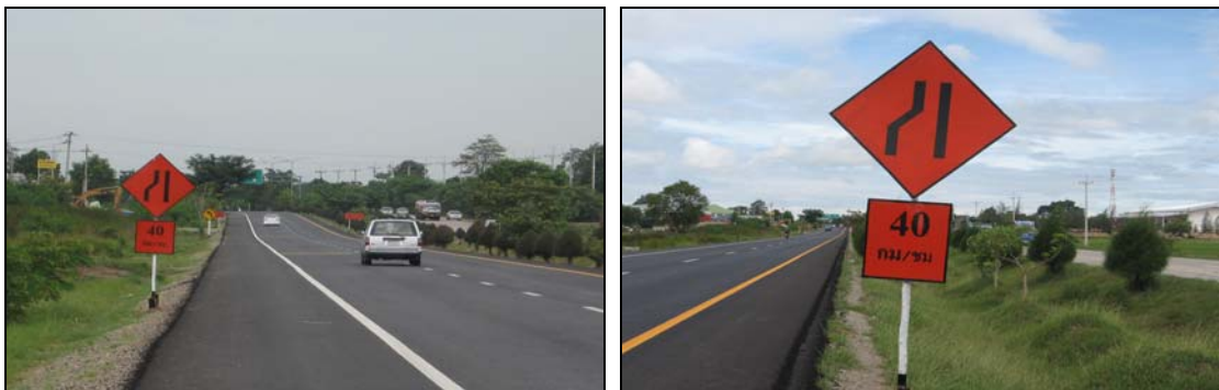
รูปที่ 3.10 การติดตั้งป้ายควบคุมการจราจรที่ 2 ป้ายทางแคบด้านซ้ายติดตั้งประกอบ กับป้ายจำกัดความเร็ว 40 กม./ชม.
