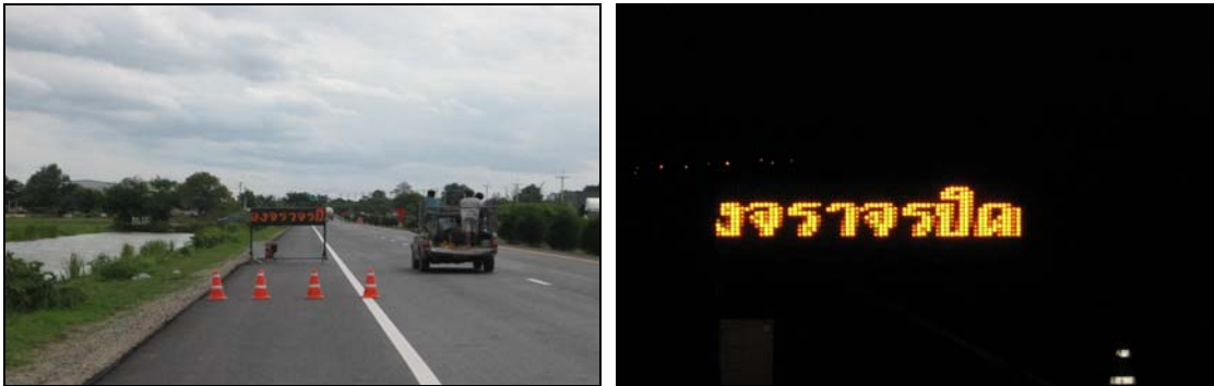
รูปที่ 3.15 การติดตั้งป้ายจราจรอิเล็กทรอนิกส์ (Variable Message Signs)
