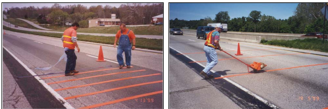
รูปที่ 2.5 การติดตั้งเส้นชะลอความเร็วในรัฐมิซูรี (Missouri)
