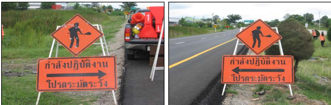
รูปที่ 3.11 การติดตั้งป้ายควบคุมการจราจรที่ 3 ป้ายเตือนคนทำงานติดตั้งประกอบ กับป้ายกำลังปฏิบัติงาน
