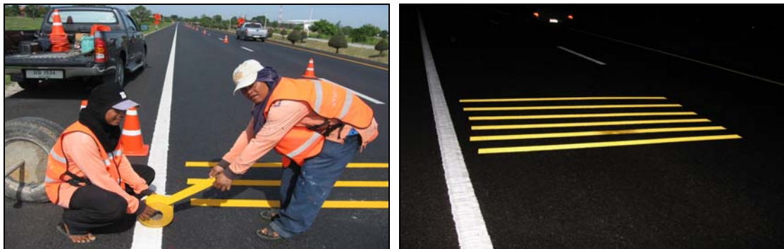
รูปที่ 3.16 การติดตั้งเส้นชะลอความเร็วแบบเคลื่อนย้ายได้ (Removable Rumble Strips)
