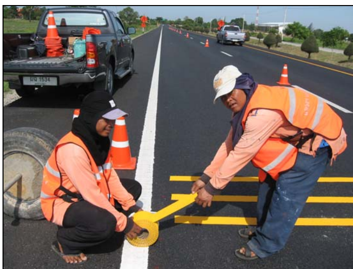
รูปที่ ๗.2 การติดตั้งเทปติสะท้อนแสง 3M
