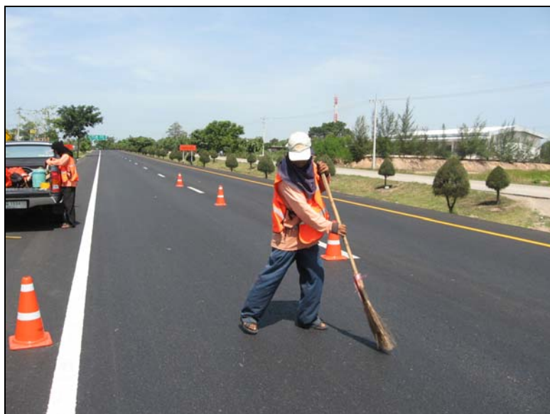
รูปที่ ข.1 การทำความสะอาดพื้นผิวจราจรก่อนการติดตั้งเทปติสะท้อนแสง 3M
