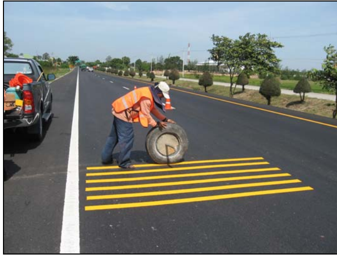
รูปที่ ซ.3 การใช้สล็อตลิ่งน้ำหนัก 90 กิโลกรัม บดทับเทปตีสะท้อนแสง
