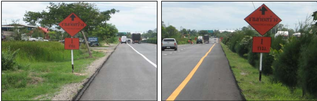
รูปที่ 3.9 การติดตั้งป้ายควบคุมการจราจรที่ 1 ป้ายบอกระยะทาง ติดตั้งประกอบกับป้ายงานก่อสร้าง
