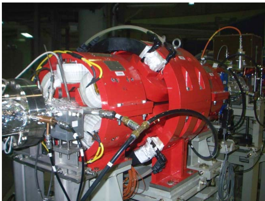
รูปที่ 6.17 การติดตั้งแม่เหล็กหกขั้วที่ใช้ขดลวดแม่เหล็กชุดใหม่
