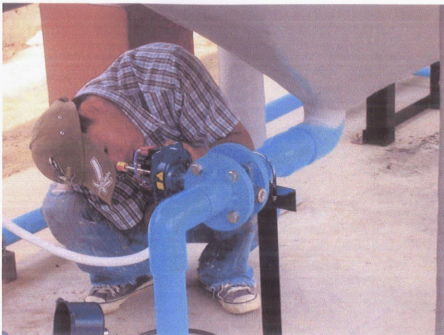
รูปที่ 5 การติดตั้งอุปกรณ์ระบบบำบัดน้ำเสีย
