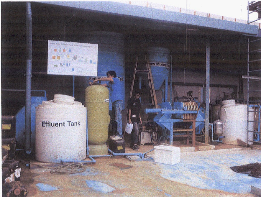
รูปที่ 22 รูปการตรวจเช็คระบบและเก็บตัวอย่างน้ำทิ้ง บริษัท โชคชัย เอ็นจิเนียริง จำกัด
