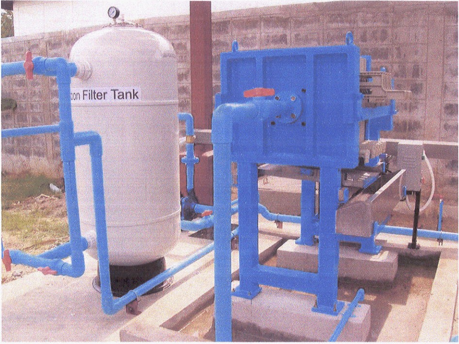
รูปที่ 19 Carbon Filter Tank และ Filter Press
