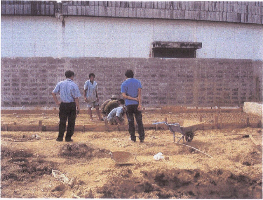
รูปที่ 3 การก่อสร้างอาคารระบบบำบัดน้ำเสีย
