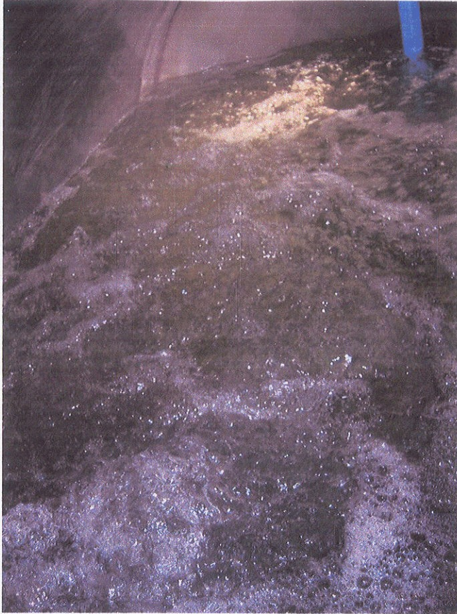
รูปที่ 17 ลักษณะน้ำเสียในถังเติมอากาศ
