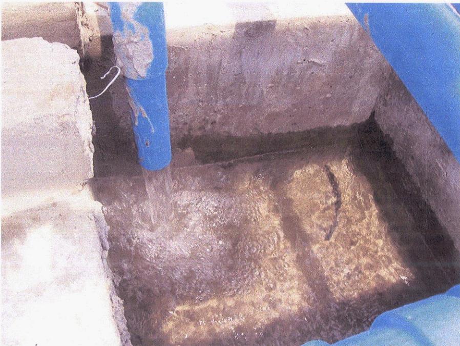
รูปที่ 18 ลักษณะน้ำทิ้งเมื่อผ่านการกรองด้วยถ่านกัมมันต์
