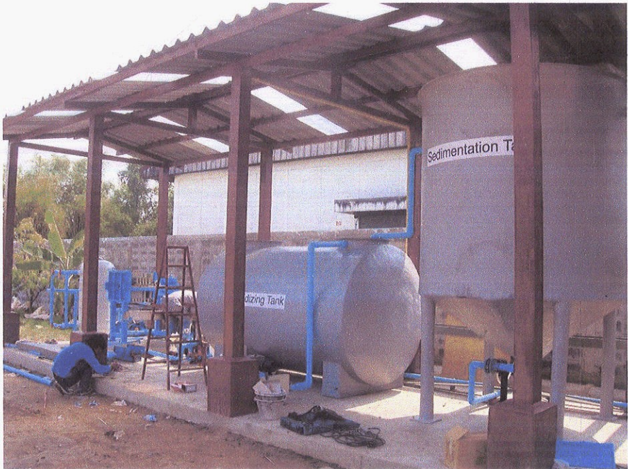
รูปที่ 8 การติดตั้งท่อระบบบำบัดน้ำเสีย
