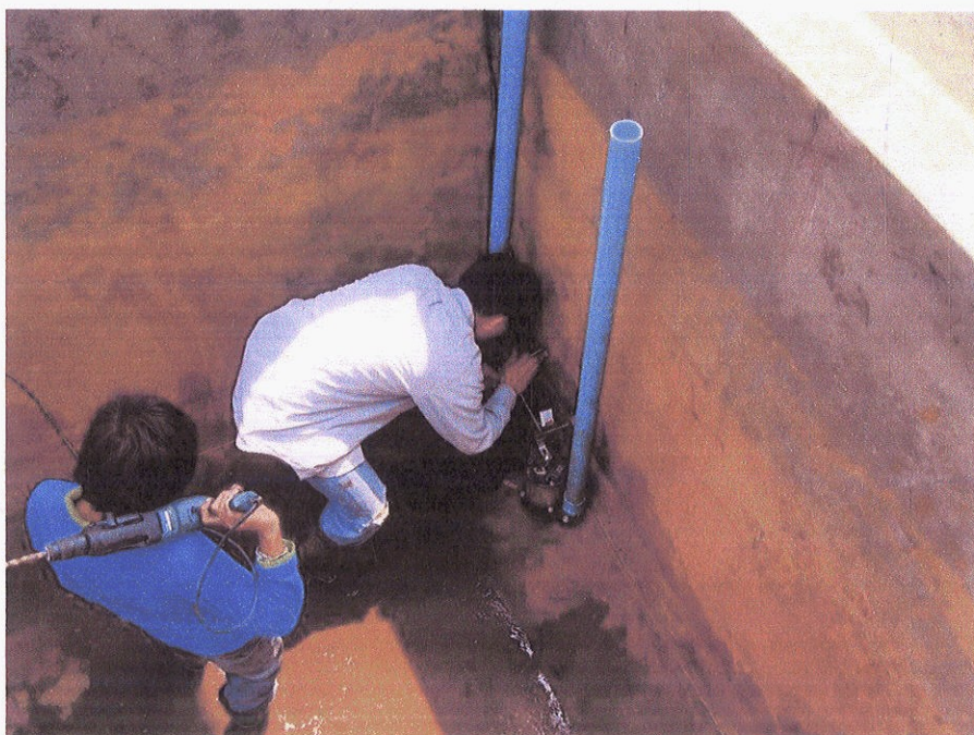
รูปที่ 6 การติดตั้งปั๊มสูบลมใน EQ Tank
