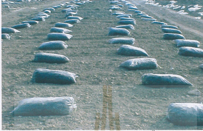
ภาพที่ 7 การปรับสภาพดินโดยใช้ซีโก้
