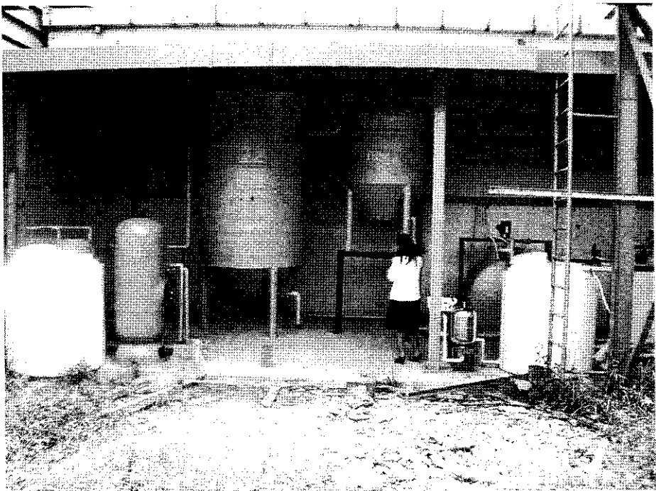
รูปที่ 3.12 ระบบบำบัดน้ำเสีย
