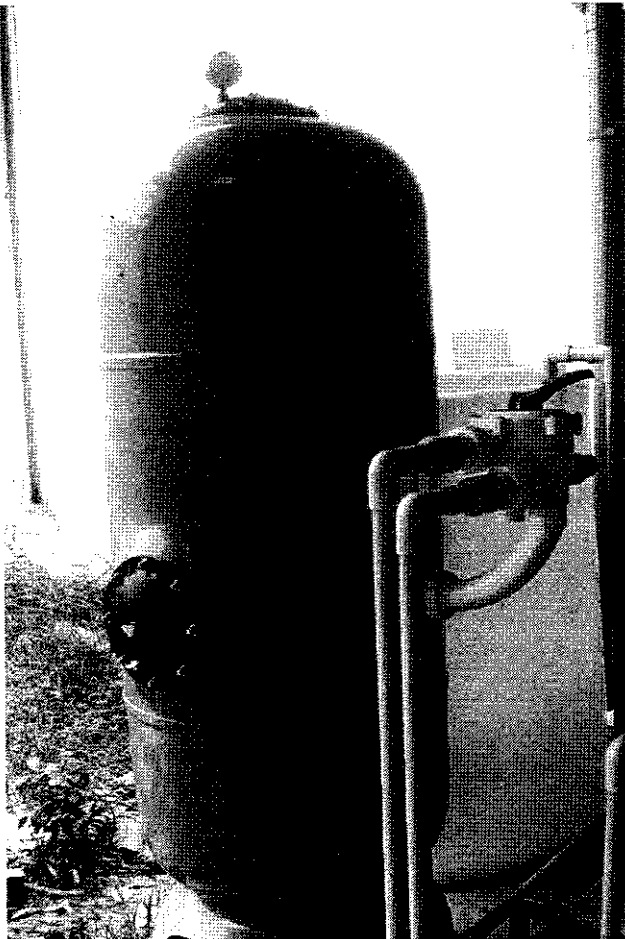
รูปที่ 3.10 Filtration Tank
