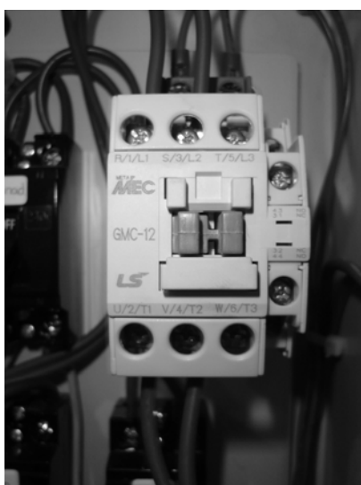
รูปที่ 3.26 Magnetic Switch ตัดต่อการทำงานของแท่งความร้อนไฟฟ้า
