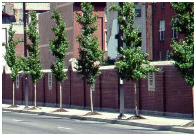
รูปที่ 2.5 กำแพงป้องกันเสียงรบกวน ประเภท คอนกรีต และ Brick Block ตามลำดับ
