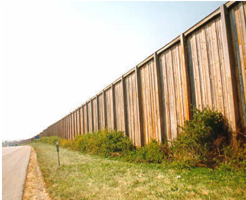
รูปที่ 2.7 กำแพงป้องกันเสียงรบกวน ประเภท ไม้ และ วัสดุโปร่งแสง ตามลำดับ
