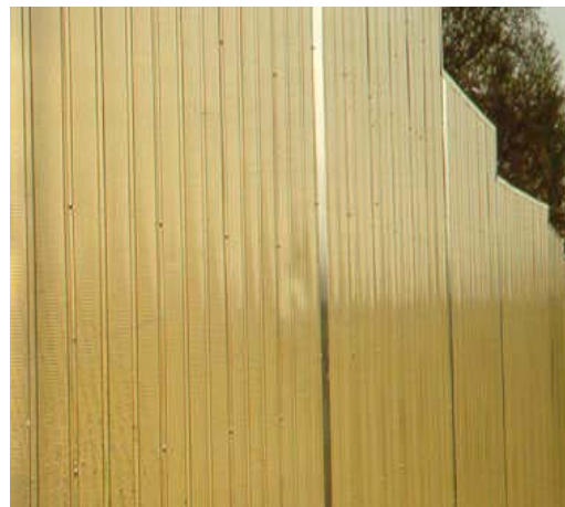
รูปที่ 2.6 กำแพงป้องกันเสียงรบกวน ประเภท Masonry Block และ โลหะผสม
