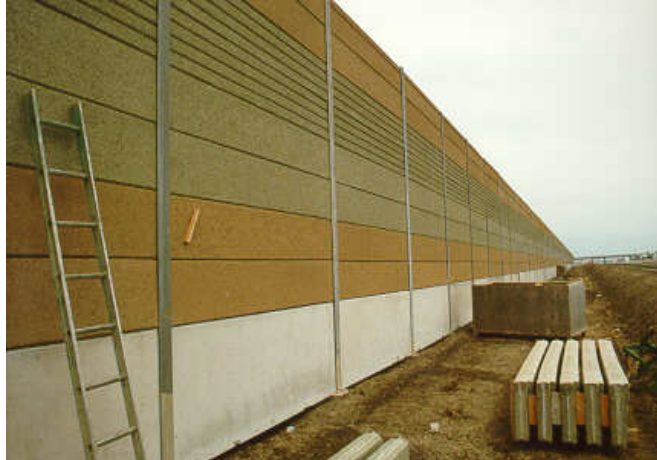
รูปที่ 2.9 กำแพงป้องกันเสียงรบกวน ประเภท Recycled Rubber และวัสดุผสม
