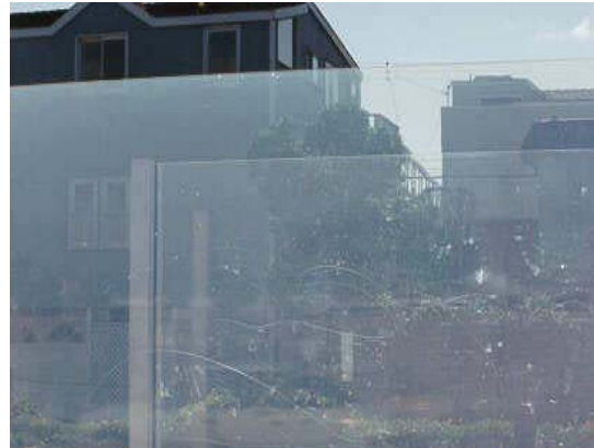
รูปที่ 2.7 กำแพงป้องกันเสียงรบกวน ประเภท ไม้ และ วัสดุโปร่งแสง ตามลำดับ
