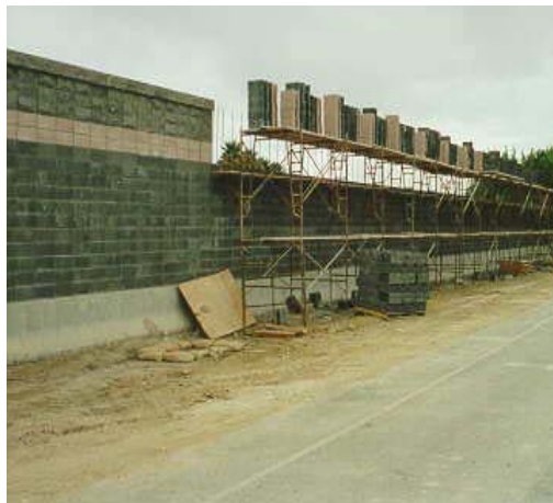
รูปที่ 2.6 กำแพงป้องกันเสียงรบกวน ประเภท Masonry Block และ โลหะผสม
