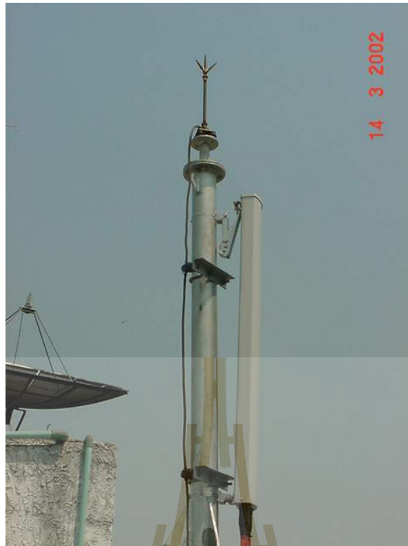
รูปที่ 2.23 แสดงสายอากาศแบบ Sector Cells
