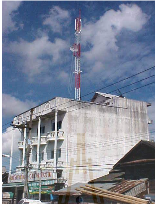
รูปที่ 2.6 สถานีฐานแบบติดตั้งอาคาร
