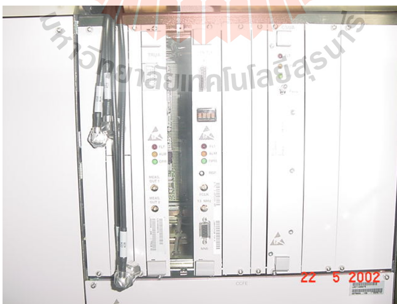
รูปที่ 2.10 Control Unit (CU)
