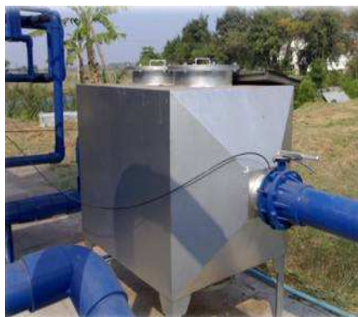
ง. ระบบกรอง (Biomass Filter Unit)
