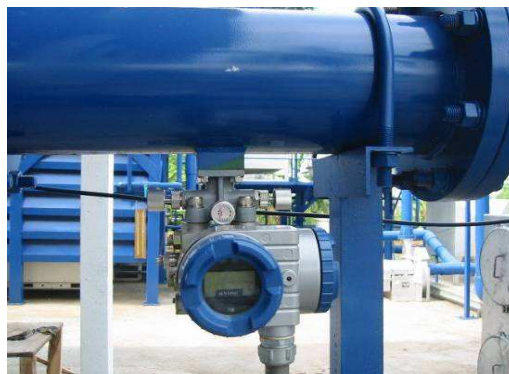
ข. Gas Flow Meter (ใช้วัด V_g )
