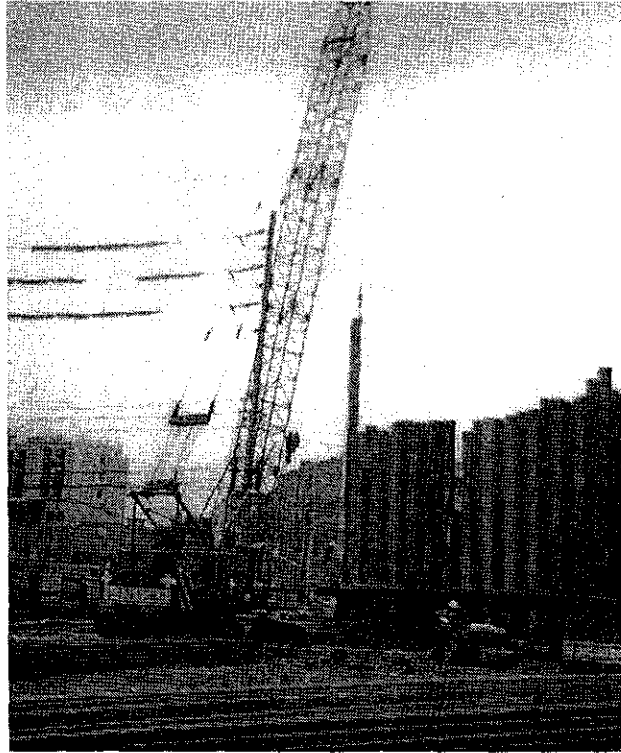
รูปที่ 6.24 การจัดวางเข็มพืดเหล็กให้ตรงแนวร่อง Interlocking
