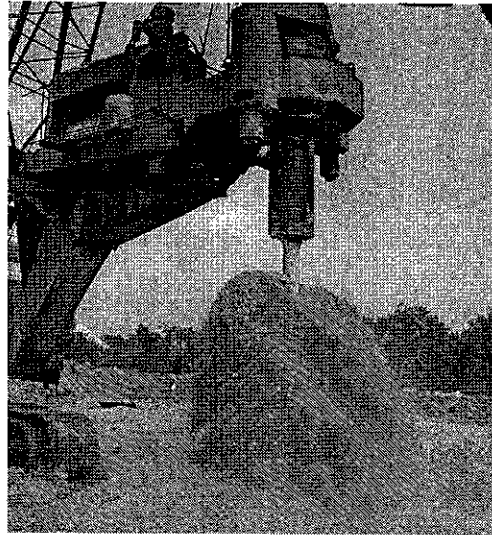
รูปที่ 3.6 การเจาะเสาเข็มเจาะแห้ง
