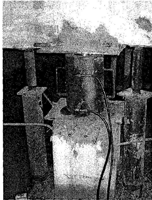
รูปที่ 3.23 การติดตั้งแม่แรงสำหรับการยกปรับระดับเสาตอม่อ
