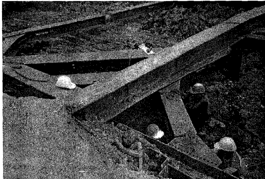
รูปที่ 6.29 การติดตั้ง Strut เข้ากับ Wale เชื่อมต่อกันด้วย Angle Reinforcement 60°
