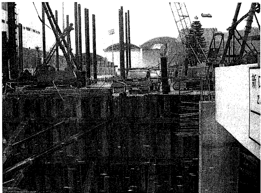
รูปที่ 6.15 ระบบ Braced cuts ในการก่อสร้างบริเวณสถานีรถไฟ มาน้ำ ประเทศจีน (ถ่ายเมื่อวันที่ 20 พฤศจิกายน 2546)
