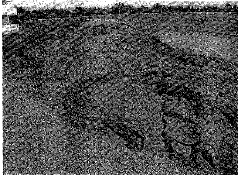
รูปที่ 4.3 การวัดตัวของลาดดินจุดอ่างเก็บน้ำภายในมหาวิทยาลัยเทคโนโลยีสุรนารี (ถ่ายเมื่อเดือนพฤษภาคม 2548)
