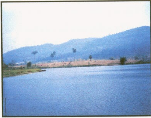
อ่างเก็บน้ำห้วยขมิ้น
