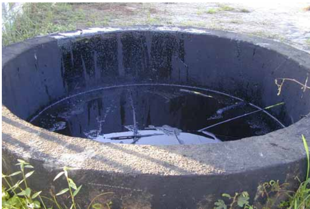
รูปที่ 3.6 น้ำมันดิบที่แทรกตัวขึ้นมาบนพื้นผิว (Oil seepage)
