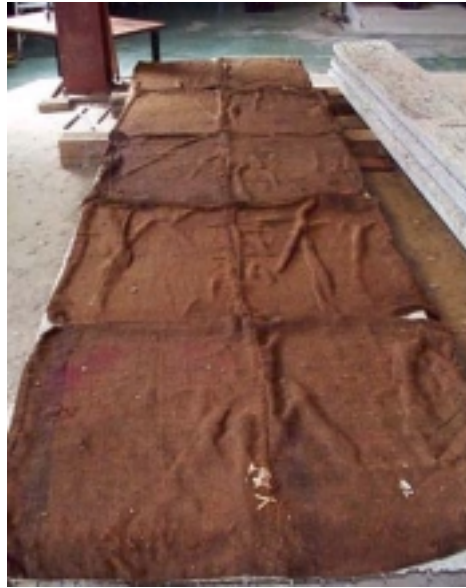
รูปที่ 3.9 พื้นคอนกรีตอัดแรงสำเร็จรูปที่บ่มด้วยกระสอบชุมน้ำ
