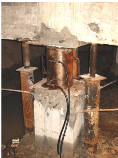
รูปที่ ค.13 ติดตั้งแม่แรงไฮดรอลิกเพื่อปรับยกอาคาร
