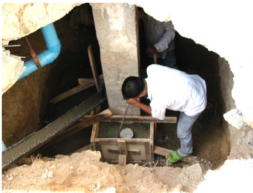
รูปที่ ค.9 เทคอนกรีต
