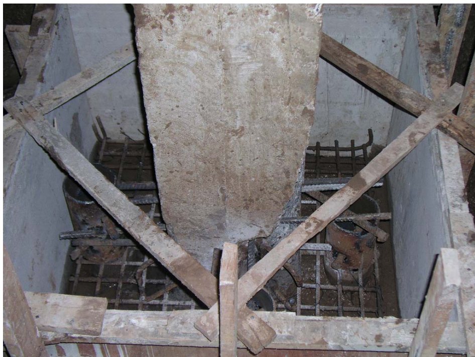
รูปที่ ค.8 ติดตั้งแบบเพื่อเทคอนกรีต
