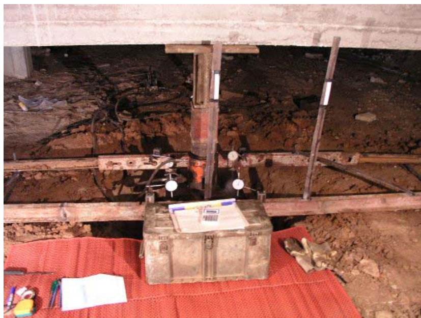
รูปที่ 3.15 การติดตั้งเครื่องมือสำหรับการทดสอบกำลังรับน้ำหนักของเสาเข็มในสนาม
