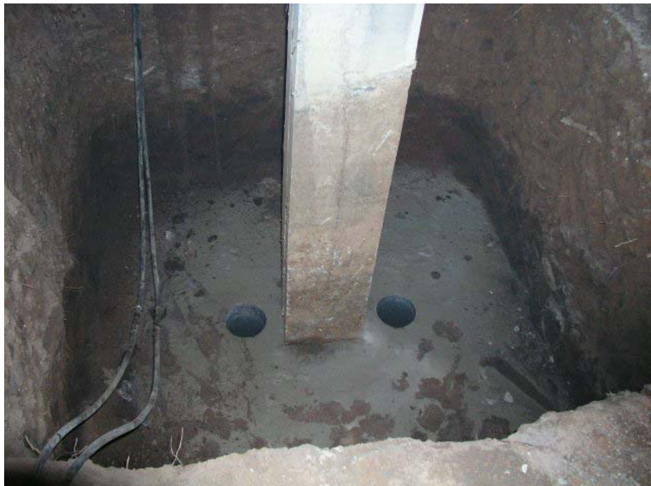
รูปที่ ค.3 รูที่ฐานรากเดิมหลังการเจาะ
