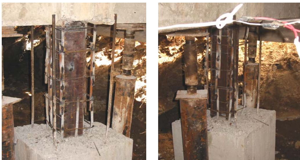
รูปที่ ค.15 ติดตั้งเหล็กแกนเสาต่อม่อ
