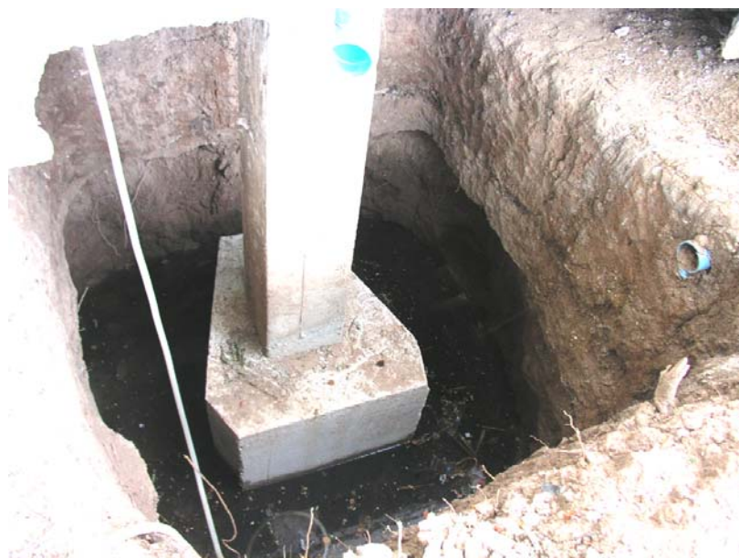
รูปที่ ค.10 สภาพฐานรากที่เสร็จเรียบร้อยแล้ว
