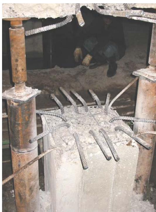
รูปที่ ค.12 ลักษณะของเสาดอม่อที่ถูกตัด
