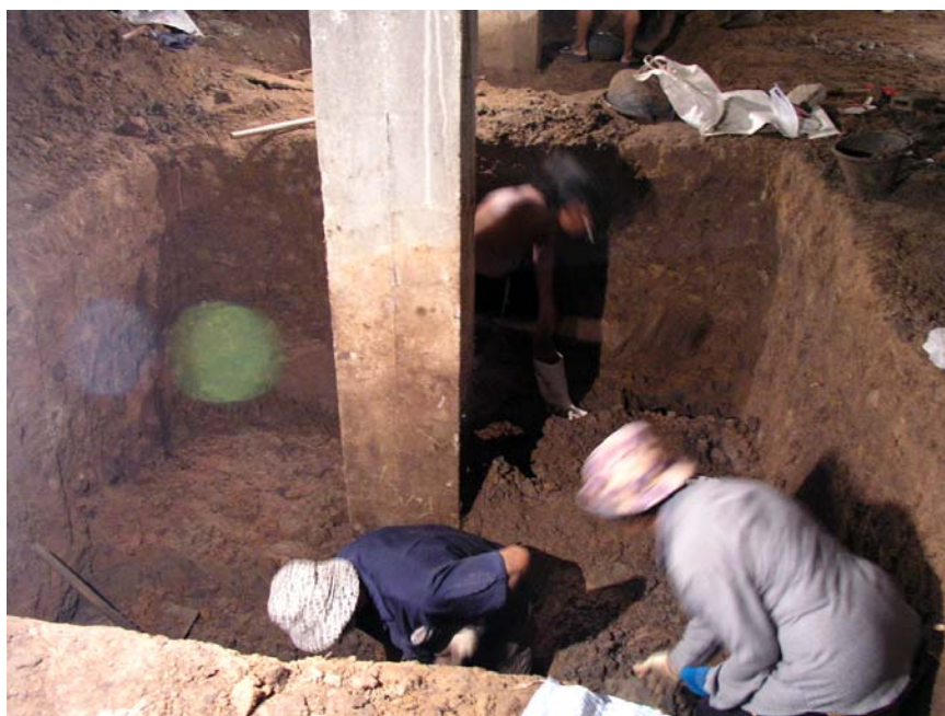
รูปที่ ค.1 ขุดหลุมให้ถึงระดับฐานรากเดิม
