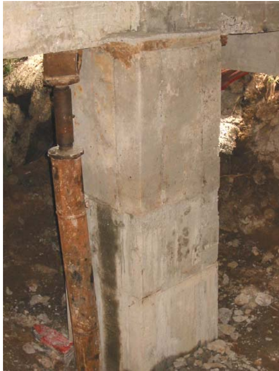
รูปที่ ค.17 ถอดแบบหล่อออก และบ่มคอนกรีตเป็นเวลา 28 วันก่อนถอดค้ำยัน
