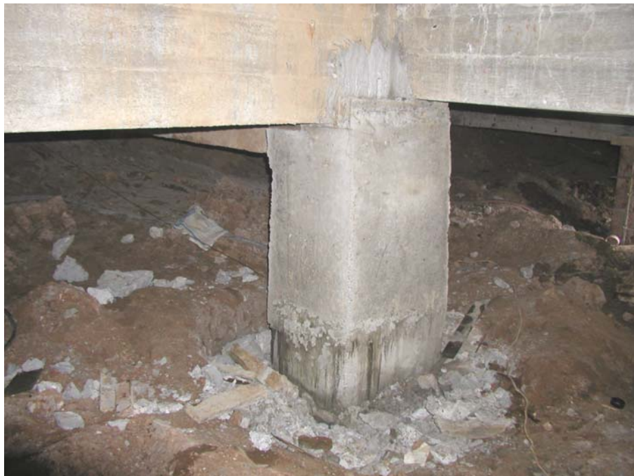
รูปที่ ค.18 สภาพของตอม่อใหม่หลังจากยกปรับระดับอาคาร
