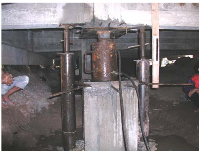
รูปที่ ค.14 การยกปรับระดับอาคารด้วยแม่แรงไฮดรอลิก
