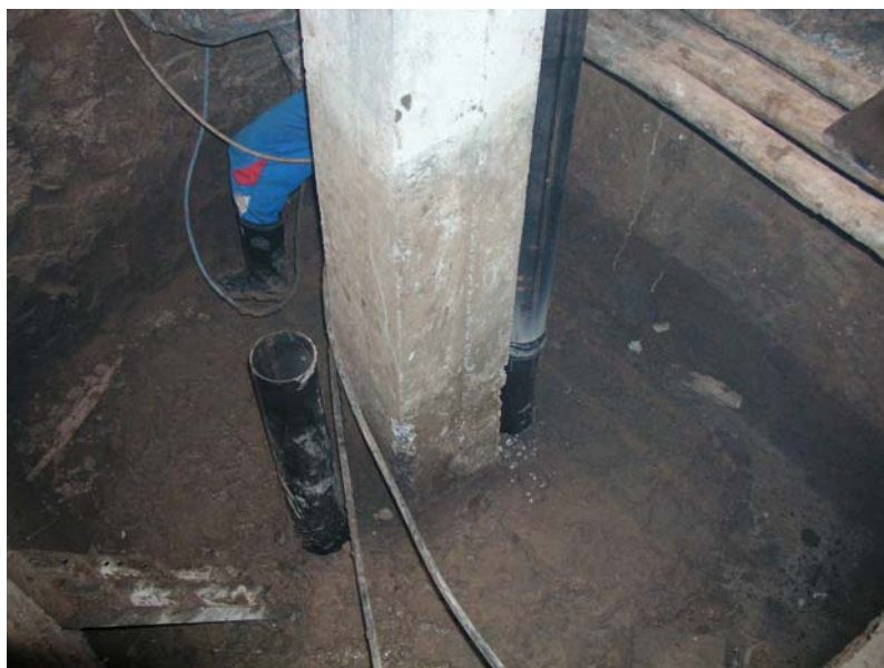
รูปที่ ค.5 เสาเข็มเหล็กที่ถูกติดตั้งในรูเจาะ
