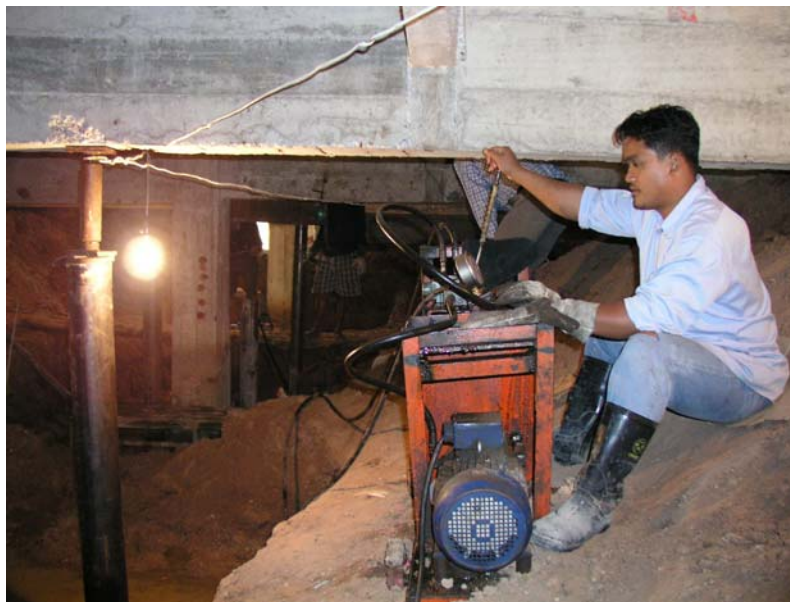
รูปที่ ค.4 การติดตั้งเสาเข็ม โดยการกดด้วยไฮดรอลิก
