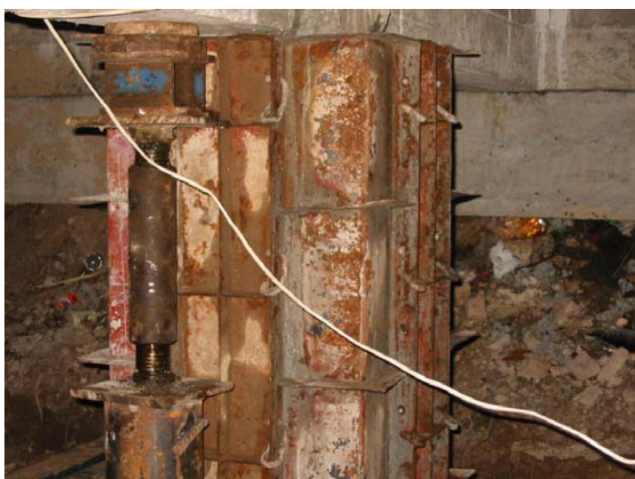
รูปที่ ค.16 ติดตั้งแบบหล่อเสาต่อม่อ
