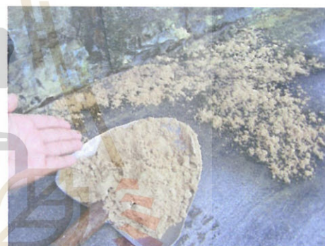
นำทรายมาดูดซับน้ำมันกรณีเกิดน้ำมันรั่วไหล
