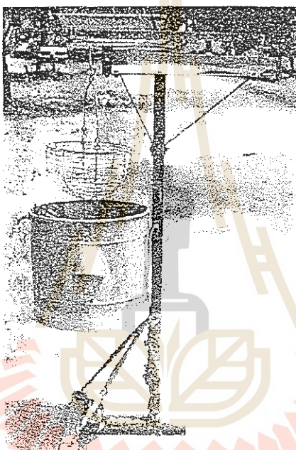
รูปที่ 2 ภาพเครื่องมือวัดความหนาแน่นของหัวมัน
