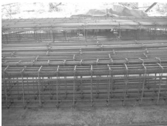
รูปที่ 3.10 การผูกเหล็กเสริมของคาน
