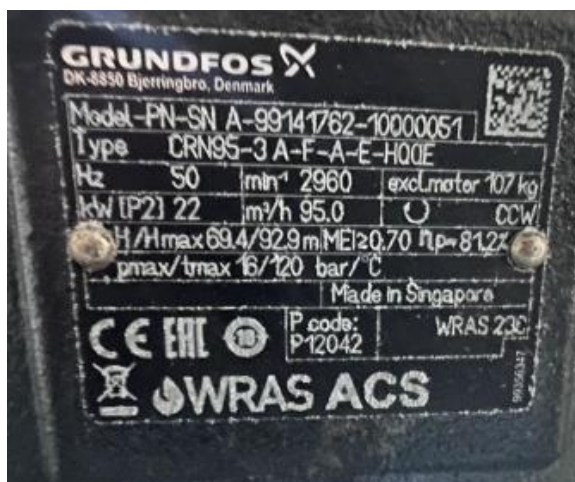
รูปที่ 4.14 เนมเพลตปั้มน้ำ DIW Booster
