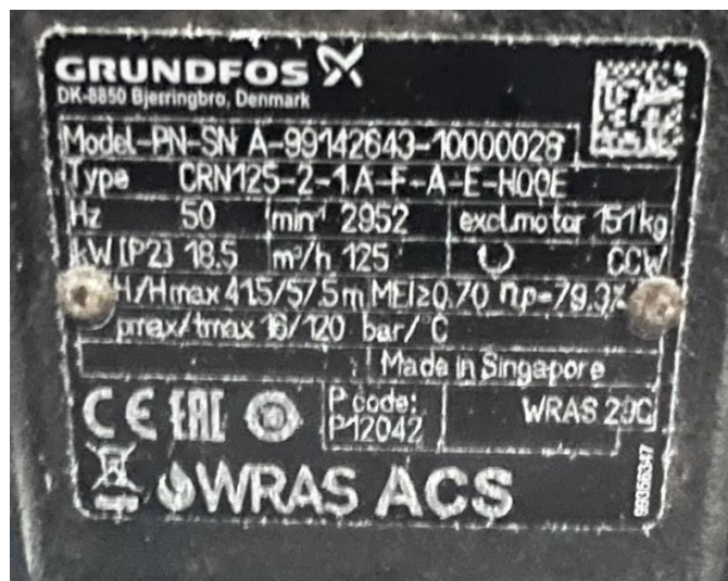
รูปที่ 4.13 เนมเพลตปั้มน้ำ DIW Distribution
