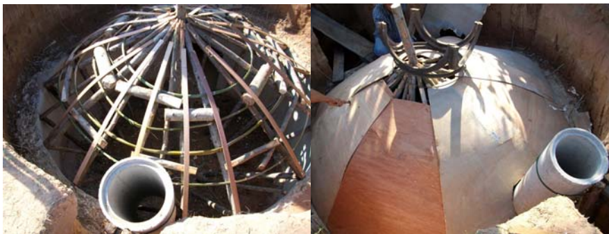
การก่อสร้าง บ่อแก๊สชีวภาพ จากแบบชั่วคราว
