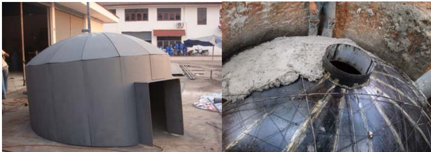
การก่อสร้าง บ่อแก๊สชีวภาพ จากแบบถาวร
