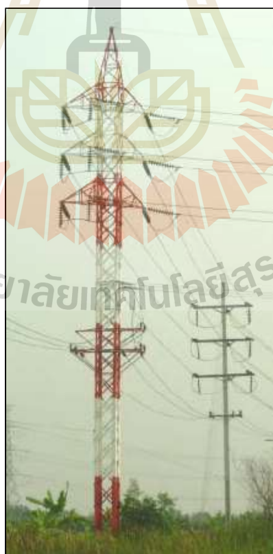
รูปที่ 2.11 เสาโครงเหล็กแบบกล่อ่งไม้ขีด
