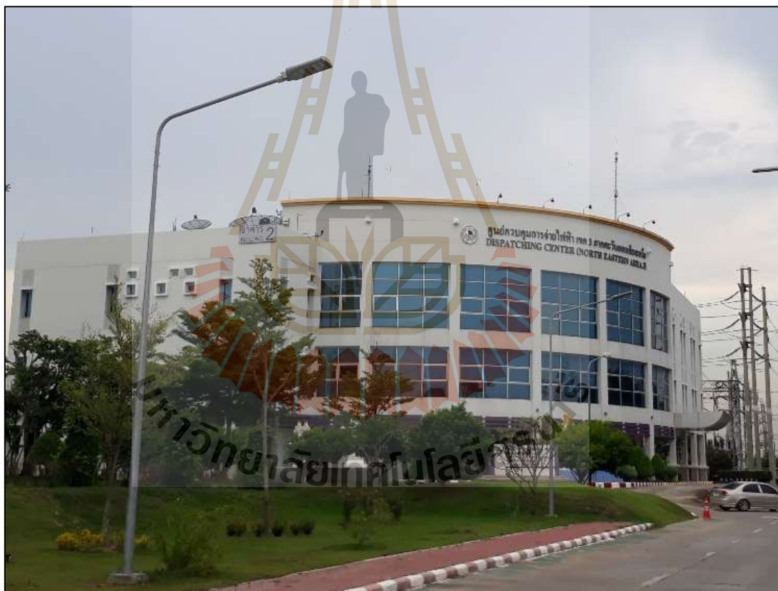
รูปที่ 2.15 ศูนย์ควบคุมการจ่ายไฟ เขต 3 ภาคตะวันออกเฉียงเหนือ
