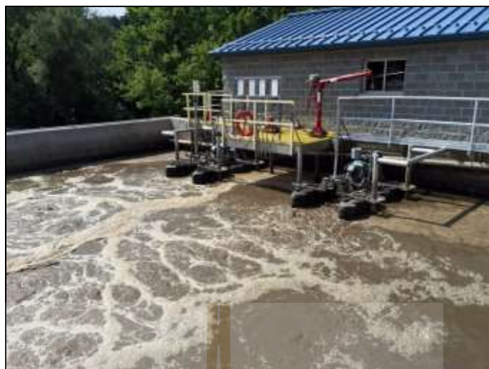
รูปที่ 3.5 ระบบบำบัดน้ำเสียแบบแอกทิเวเตดสลัดจ์
