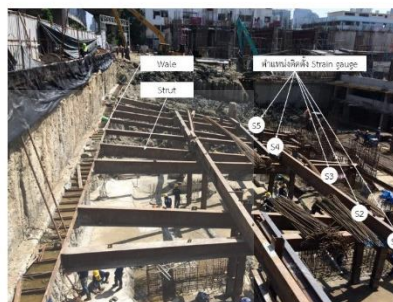
รูปที่ 27 ภาพแสดงตำแหน่ง Wale, Strut และ Strain gauge
