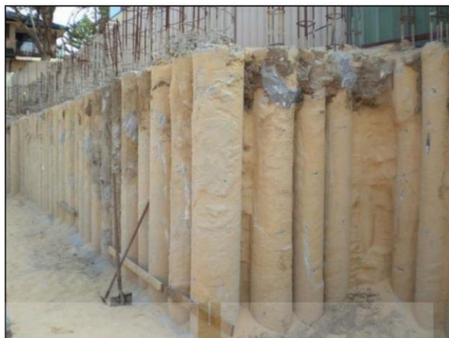
รูปที่ 2.30 ลักษณะของดินที่ไหลออกตามซอกเข็ม (ประจิด จีรปภา, 2539)
