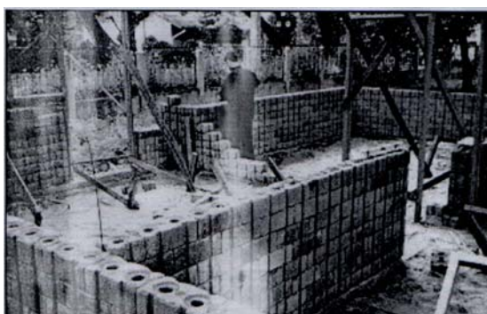
รูปที่ 1.1 การก่อสร้างผนังรับน้ำหนักด้วยอิฐดินซีเมนต์
