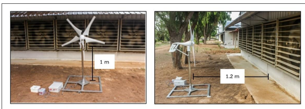
รูปที่ 8.10 การติดตั้งระบบผลิตไฟฟ้าจากระบบระบายอากาศของโรงเรียน
