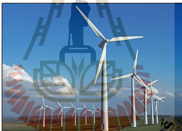
รูปที่ 3.5 กังหันลมแบบแนวแกนนอน
