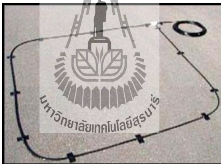
รูปที่ 2.13 Inductive Loop บนถนน
