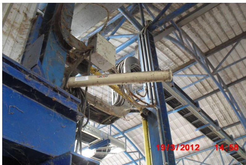
รูปที่ 3.32 สายอากาศภาคส่งจากโรงป้อนชีวภาพ
