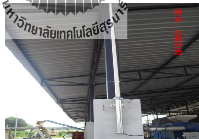
รูปที่ 3.27 สายอากาศภาครับบ่อเลี้ยงปลา
