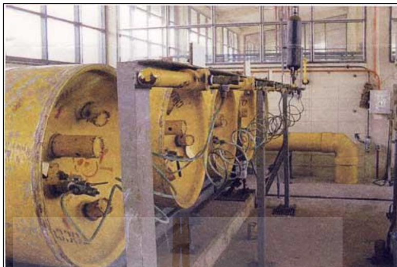
รูปที่ 2.9 การเติมคลอรีนแก๊สในการฆ่าเชื้อโรค
