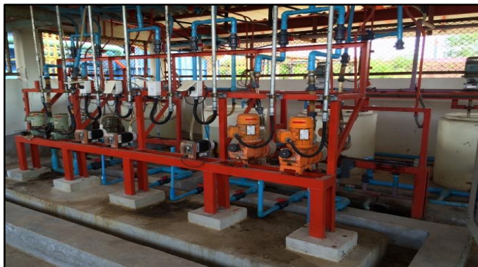
รูปที่ 2.6 ถังสารเคมีที่ใช้เติมให้กับระบบผลิตน้ำประปา (ระบบประปา มทส.)
