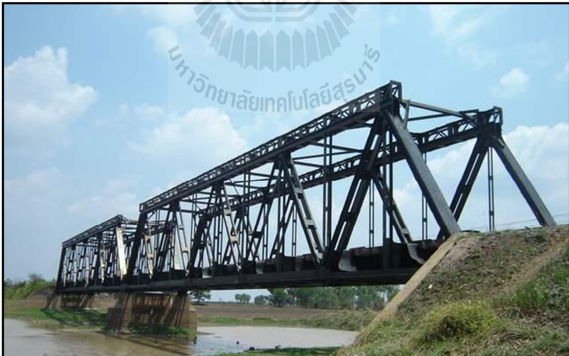
รูปที่ 2.1 โครงสร้างสะพานที่ทำจากเหล็ก (รถไฟไทยดอทคอม. http://portal.rotfaithai.com )
