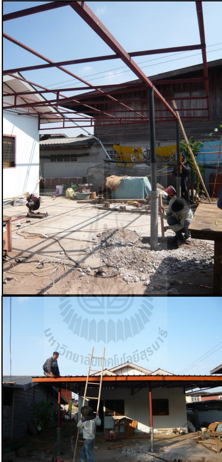
รูปที่ 4.4 งานต่อเติมอาคารเพื่อทำกันสาด
