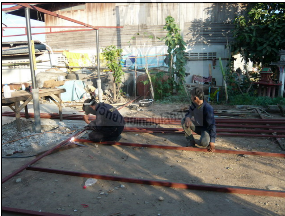
รูปที่ 4.3 การเชื่อมต่อเหล็กหน้างาน
