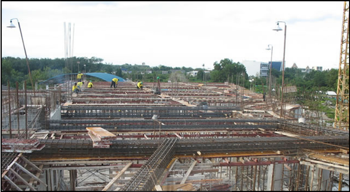
รูปที่ 2.2 การใช้เหล็กในงานก่อสร้างอาคารคอนกรีตเสริมเหล็ก ( http://multimedia.hu.ac.th )
