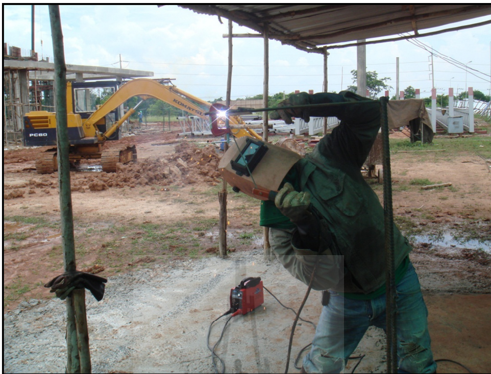
รูปที่ 3.5 การทดสอบช่างเชื่อมในตำแหน่งทำเหนือศีรษะ (Overhead Position Welding)
