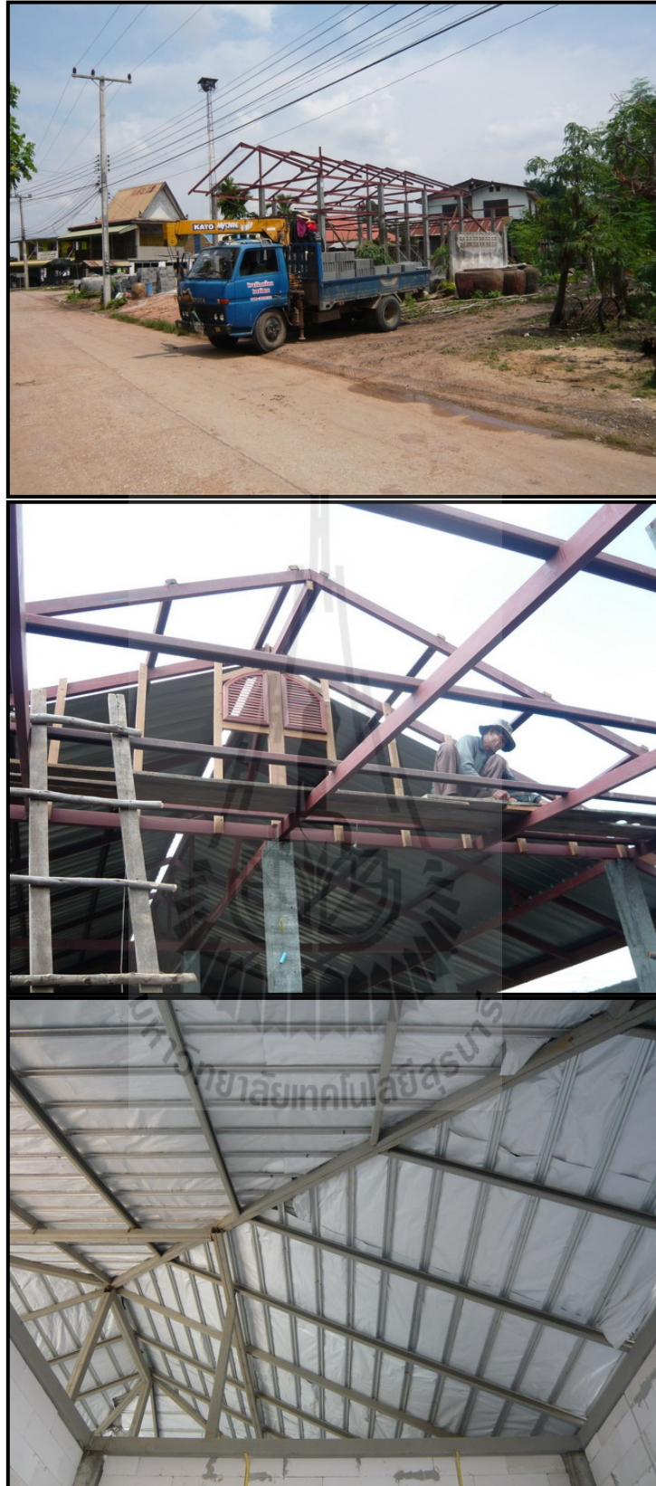
รูปที่ 4.4 งานโครงสร้างหลังคา
