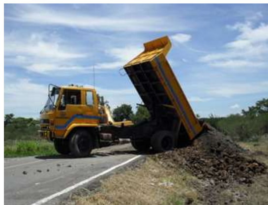
รูปที่ 4.5 ข. การกองเก็บดินคันทางที่รี้ออก ด้วยรถบรรทุกเทท้ายแบบ 6 ล้อ
