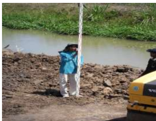
รูปที่ 4.4 ข. การตรวจสอบระดับความลึกของ คันทางที่รื้อออกในแปลงทดลองที่ 2
