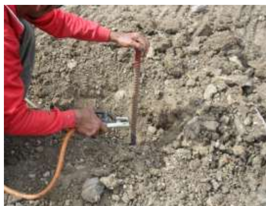
รูปที่ 4.10 ข. การต่อแกนเหล็กของ Settlement Plate
