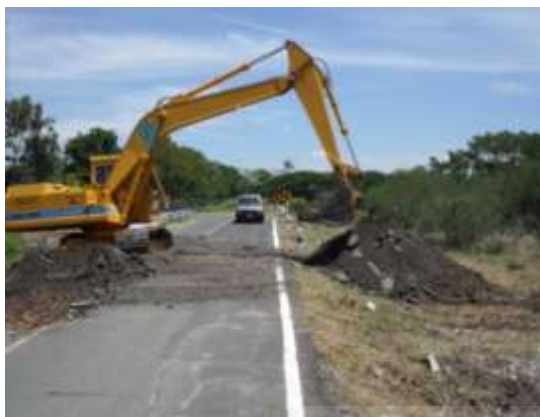
รูปที่ 4.5 ก. การกองเก็บดินคันทางที่รี้ออก ด้วยรถขุดไฮดรอลิก
