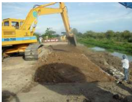
รูปที่ 4.13 ข. การถมกลับลูกรังในแปลง ทดลองที่ 2
