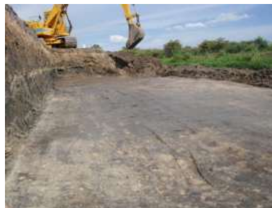
รูปที่ 4.7 ข. การปูแผ่นใยสังเคราะห์ ชั้นที่ 1 ของแปลงทดลองที่ 2
