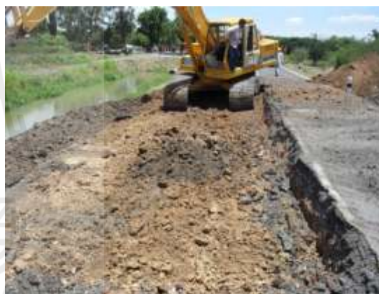
รูปที่ 4.3 ข. การรื้อผิวทาง โครงสร้างทาง และ คันทางเดิมแปลงทดลองที่ 2
