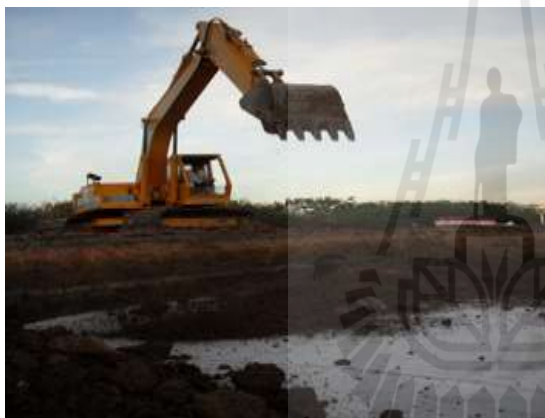
รูปที่ 4.9 ก. การถมกลับด้วยรถขุดไฮดรอลิก
