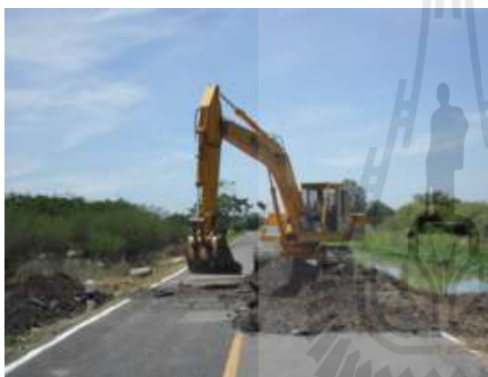
รูปที่ 4.3 ก. การรื้อผิวทาง โครงสร้างทาง และ คันทางเดิมแปลงทดลองที่ 1
