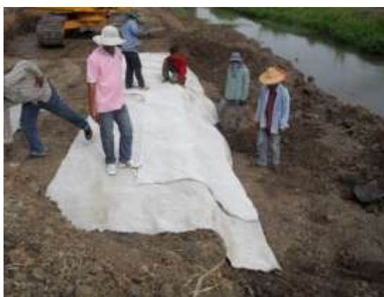
รูปที่ 4.10 ก. การพับปลายแผ่นใยสังเคราะห์ กลับบนดินถมคันทางชั้นที่ 1
