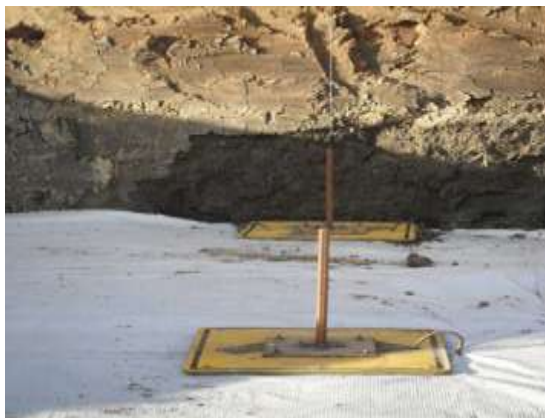
รูปที่ 4.8 ก. การติดตั้ง Settlement Plate ในแปลงทดลองที่ 1
