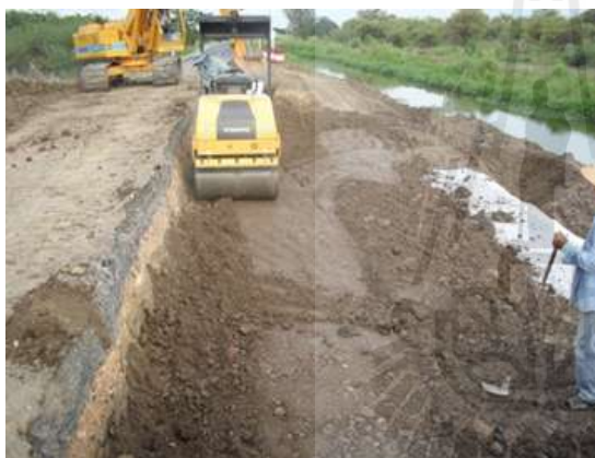
รูปที่ 4.12 ก. การบดอัดดินด้วยรถกดแบบล้อ ผสมในแปลงทดลองที่ 1
