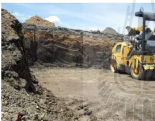
รูปที่ 4.6 ก. การบดอัดดินฐานราก
