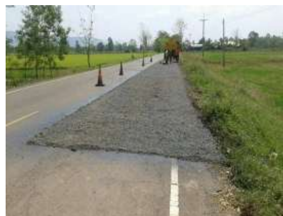
รูปที่ 4.16 ข. การทำผิวจราจรแปลงทดลองที่ 2
