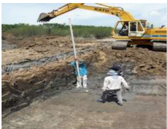
รูปที่ 4.4 ก. การตรวจสอบระดับความลึกของ คันทางที่รื้อออกในแปลงทดลองที่ 1
