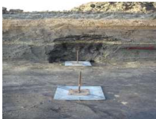
รูปที่ 4.8 ข. การติดตั้ง Settlement Plate ในแปลงทดลองที่ 2
