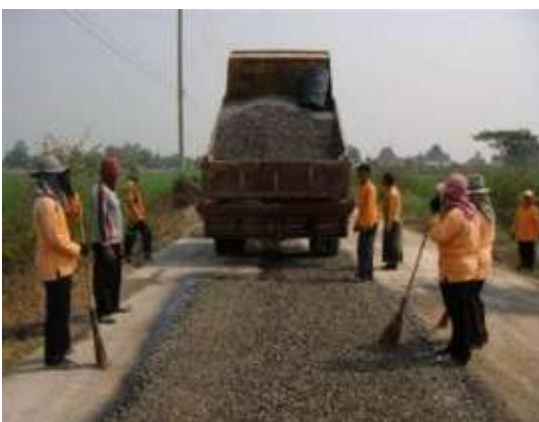
รูปที่ 4.16 ก. การทำผิวจราจรแปลงทดลองที่ 1
