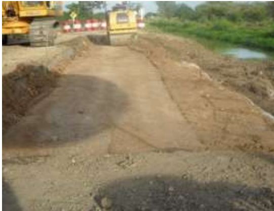
รูปที่ 4.14 ก. การบดอัดลูกรังด้วยรถบดแบบล้อผสม
