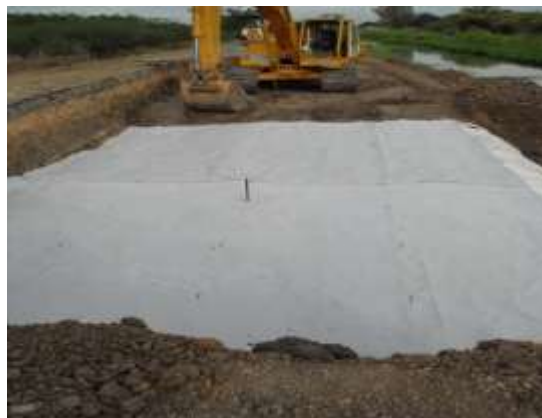
รูปที่ 4.11 ข. การปูแผ่นใยสังเคราะห์ ชั้นที่ 2 ในแปลงทดลองที่ 1
