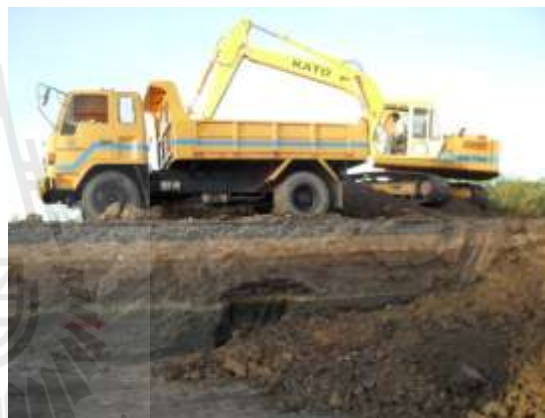
รูปที่ 4.9 ข. การถมกลับด้วยรถบรรทุกเท ท้าย แบบ 6 ล้อ
