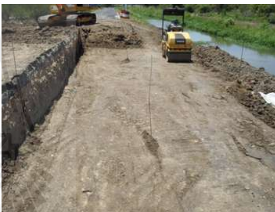
รูปที่ 4.12 ข. การบดอัดดินด้วยรถกดแบบ ล้อผสมในแปลงทดลองที่ 2
