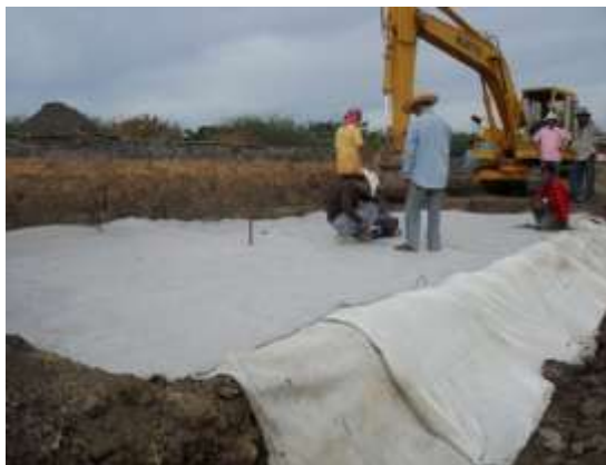
รูปที่ 4.11 ก. การปูแผ่นใยสังเคราะห์ ชั้นที่ 2 ในแปลงทดลองที่ 1
