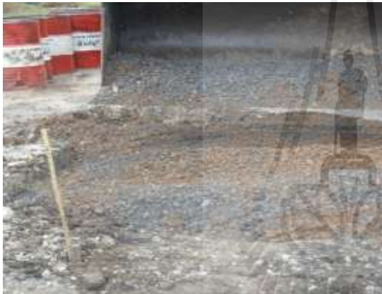
รูปที่ 4.15 ก. การถมกลับชั้นหินคลุก
