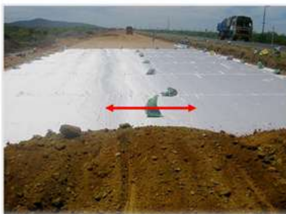
รูปที่ 4.17 การปูวัสดุเสริมแรงในคันทางที่ถุกวิธี
