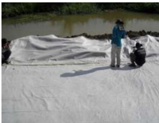
รูปที่ 4.7 ก. การปูแผ่นใยสังเคราะห์ ชั้นที่ 1 ของแปลงทดลองที่ 1
