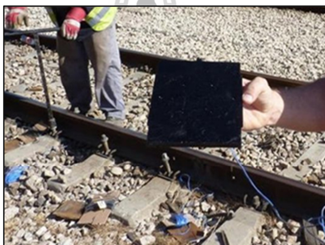
รูปที่ 2.12 แผ่น IPEG PADs กำลังถูกติดตั้งบนรางรถไฟ
