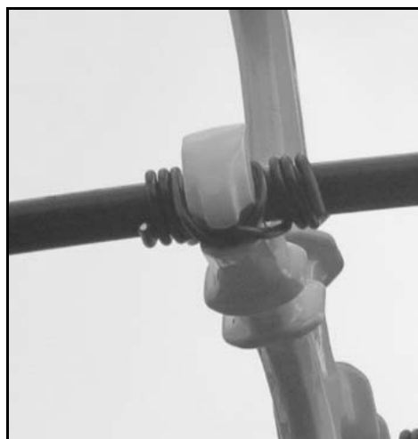
รูปที่ 3.6 ตัวรัดสายแบบเส้นลวดอูมเนียมหุ้มด้วยฉนวนพอลิเอทิลีน
