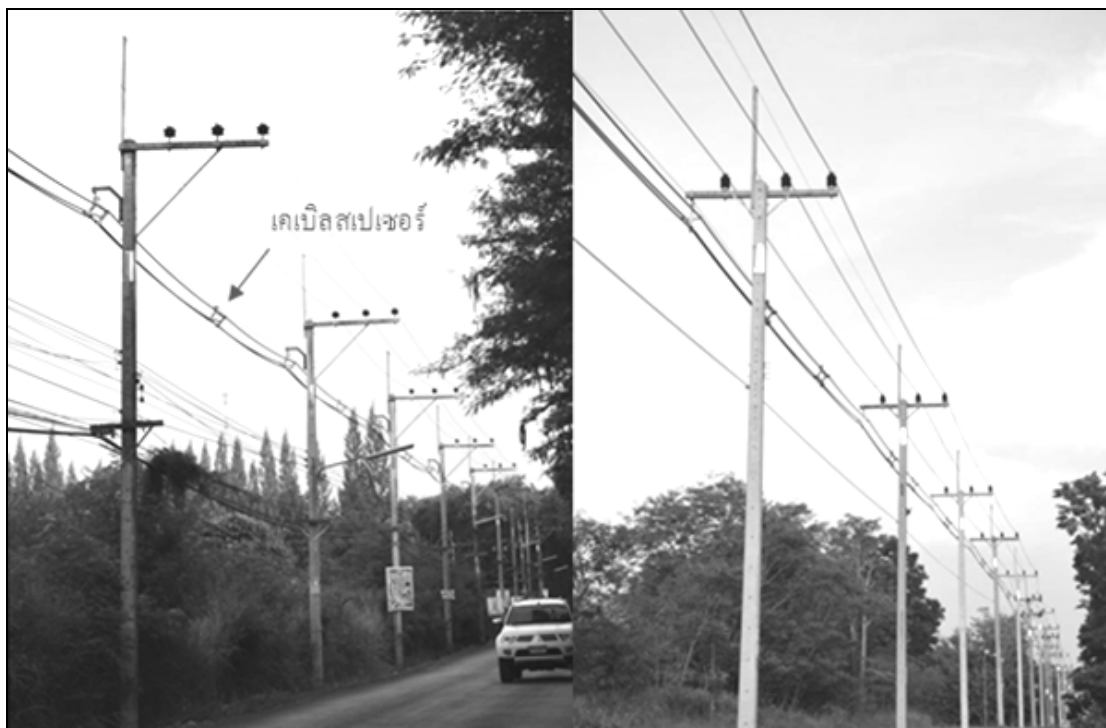
รูปที่ 1.1 การใช้เคเบิลสเปเซอร์ช่วยในการพาดสายไฟฟ้าแบบใหม่
