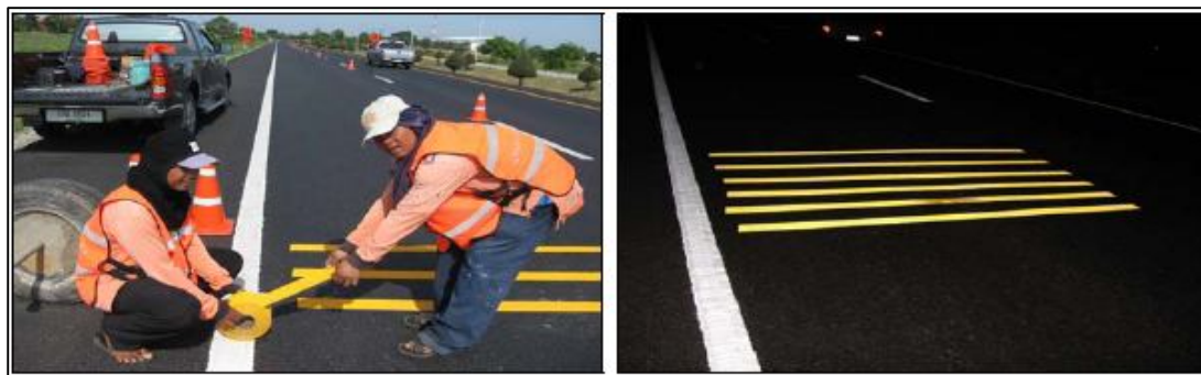
รูปที่ 2.1 การติดตั้งป้ายจราจรอิเล็กทรอนิกส์ (Variable Message Signs)
