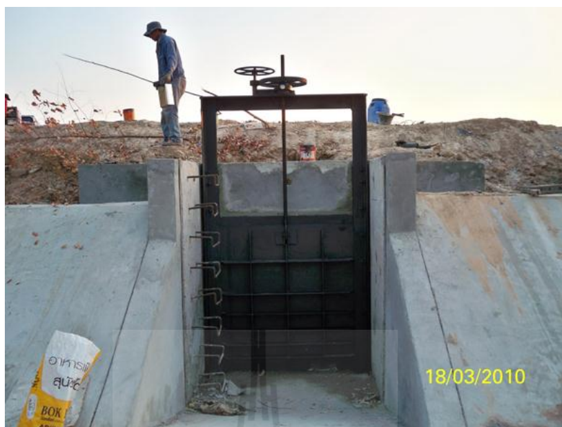
รูปที่ 4.6 โครงการก่อสร้างประตูระบายน้ำ
