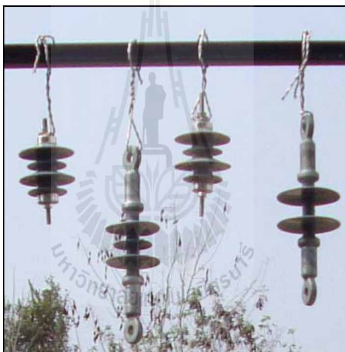
รูปที่ 5.7 การติดตั้งลูกถ้วยฉนวนพอลิเมอร์
