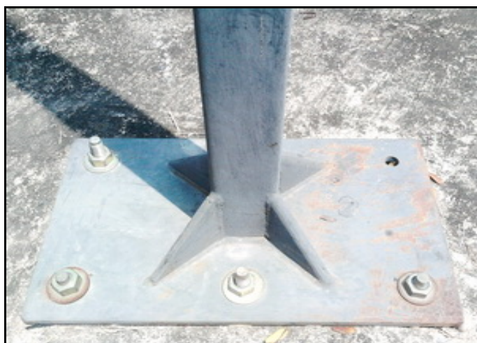
รูปที่ 4.20 ฐานสี่เหลี่ยมสำหรับยึดตัว โครงเหล็กกับพื้นปูน
