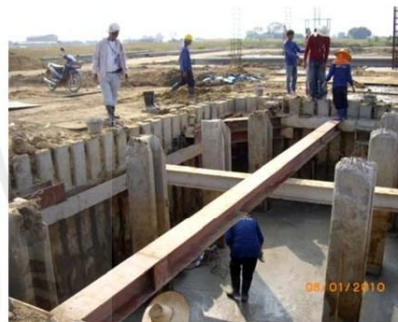
รูปที่ 1 การใช้เสาเข็มตอกเรียงต่อเนื่องรูปตัวไอในการขุดเพื่อก่อสร้างฐานราก
