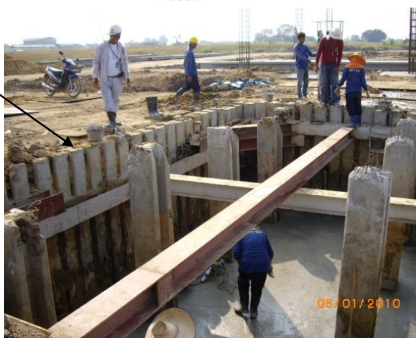
รูปที่ 2.3 งานขุดดินโดยใช้ระบบกำแพงกันดินแบบเสาเข็มตอกเรียงต่อเนื่อง
