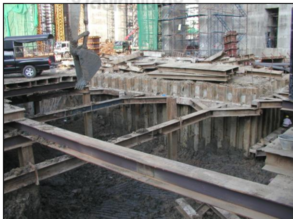
รูปที่ 2.1 งานขุดดินโดยใช้ระบบกำแพงกันดินแบบเข็มพืดเหล็ก
