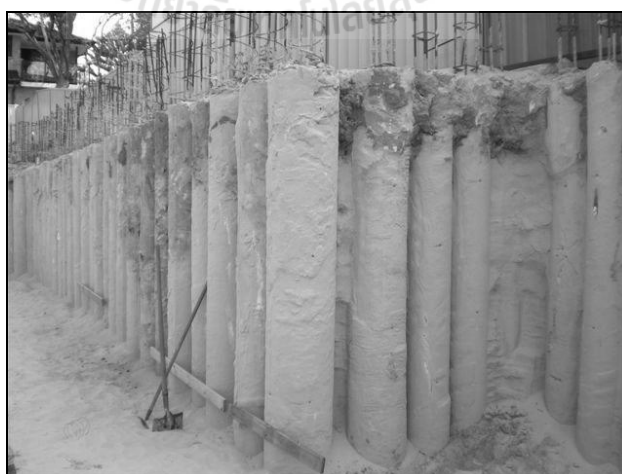
รูปที่ 2.6 ลักษณะของดินที่ไหลออกตามซอกเข็ม
