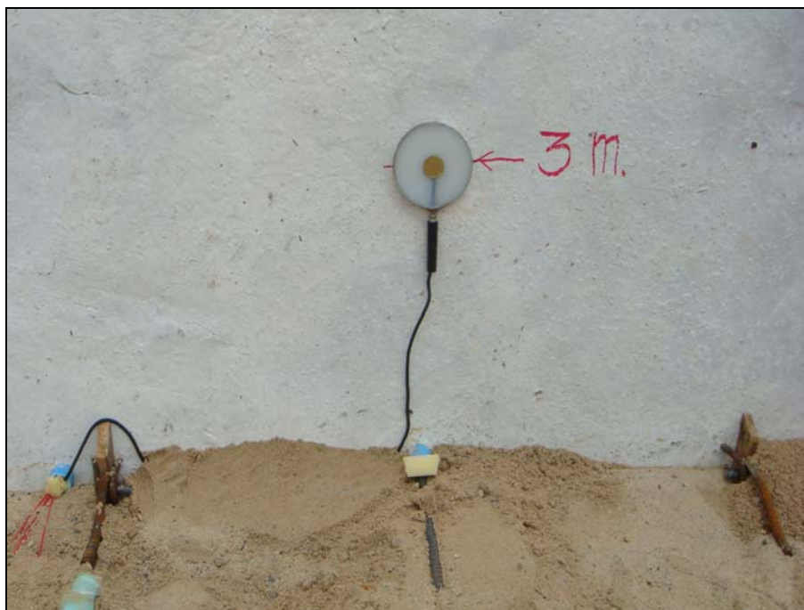
รูปที่ 3.9 การติดตั้งอุปกรณ์วัดความเค้นในดินที่แผ่นกำแพง
