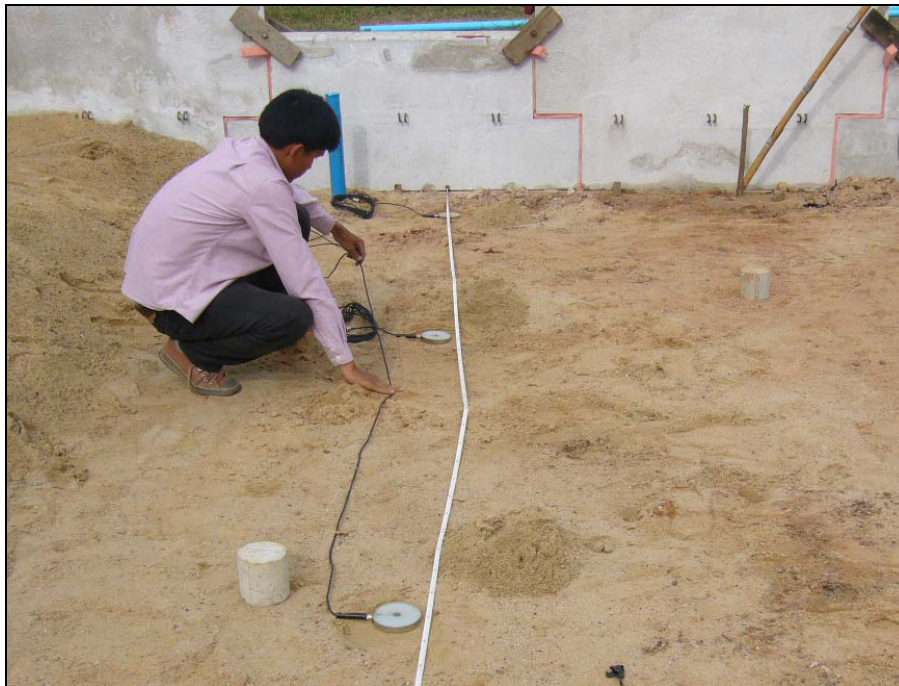
รูปที่ 3.8 การติดตั้งอุปกรณ์วัดความเค้นในดินที่ระดับฐานราก
