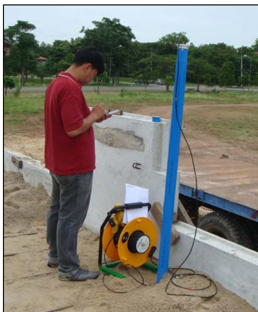
รูปที่ 3.11 การติดตั้งอุปกรณ์วัดการเคลื่อนตัวในแนวราบ (Inclinometer)
