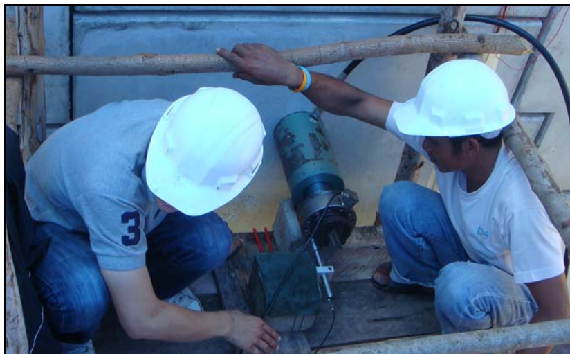
รูปที่ 3.12 การติดตั้งอุปกรณ์สำหรับดึงเหล็กเสริมแบกทานในสนาม
