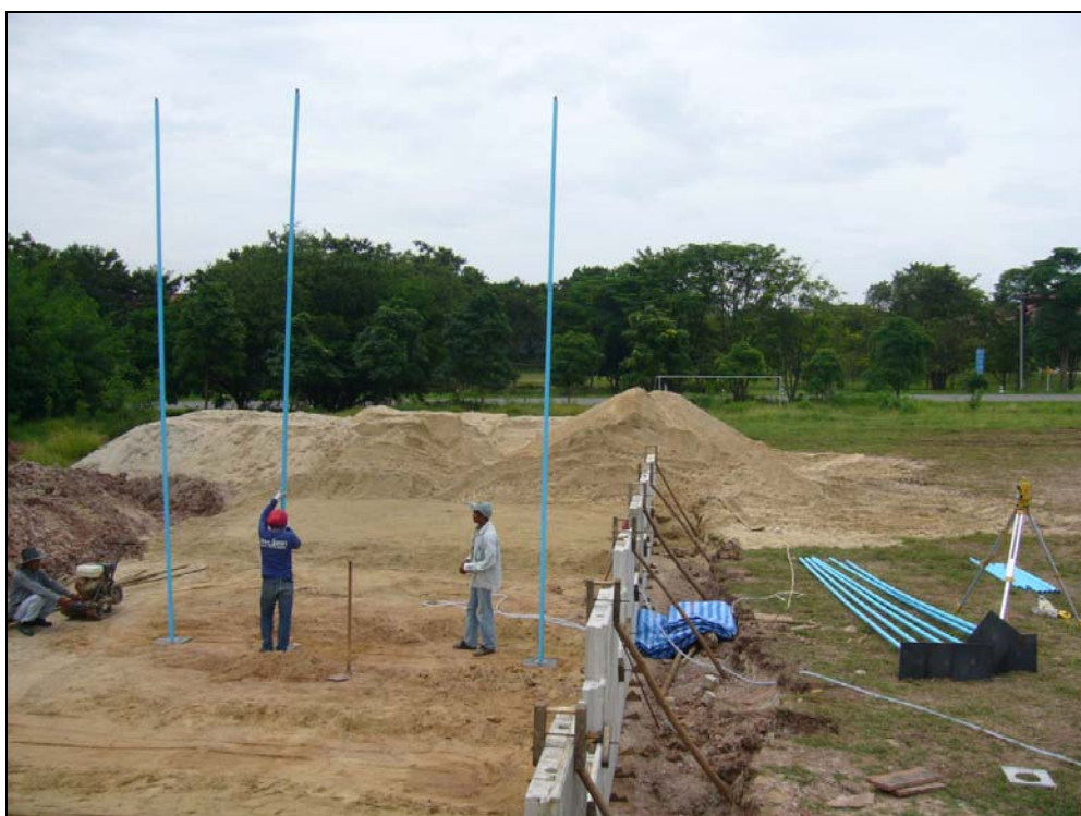
รูปที่ 3.7 การติดตั้งแผ่นเหล็กวัดการทรุดตัว
