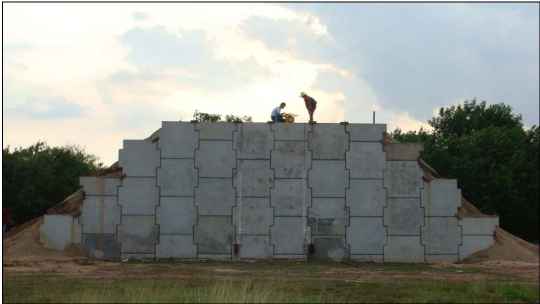
รูปที่ 3.5 การทดสอบกำแพงกันดินเหล็กเสริมแบกทาน
