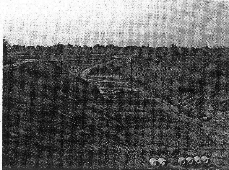
การขุดอ่างเก็บน้ำ และก่อสร้างคันดินอ่างเก็บน้ำ
